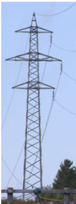
Figur 2-4: Eksisterende fagverksmaster mellom Fjærå og Skytterhuset.
