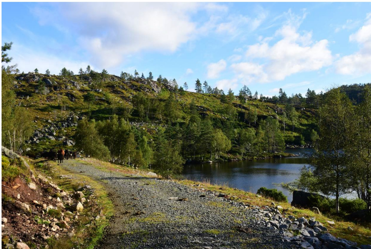
Figur 2-7. Vestre ende (utløpet) av Ljosvatnet med anleggsvei til eksisterende dam. Foto: Sweco Norge.
