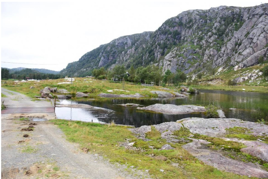
Figur 2-8. Utløpsterskel kombinert med driftsveg ved utløpet av Sætravatnet. Innfelt nærbilde av utløpsterskel. Foto. Sweco Norge og Rolf Amundsen .
