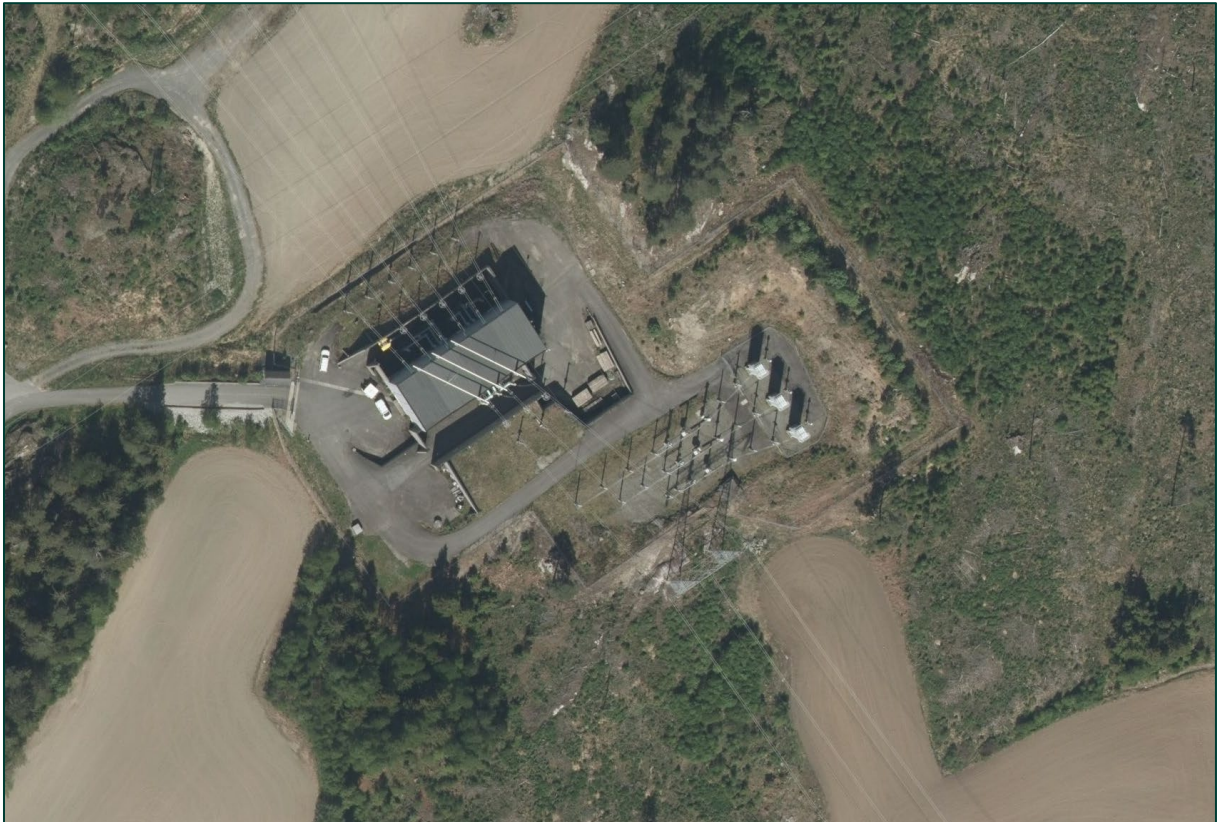
Figur 1 Statnett ønsker å beholde bygningsmasse og stasjonsgjerde på eksisterende Tegneby transformatorstasjon. Utendørs og innendørs høyspentanlegg skal flyttes/saneres.
