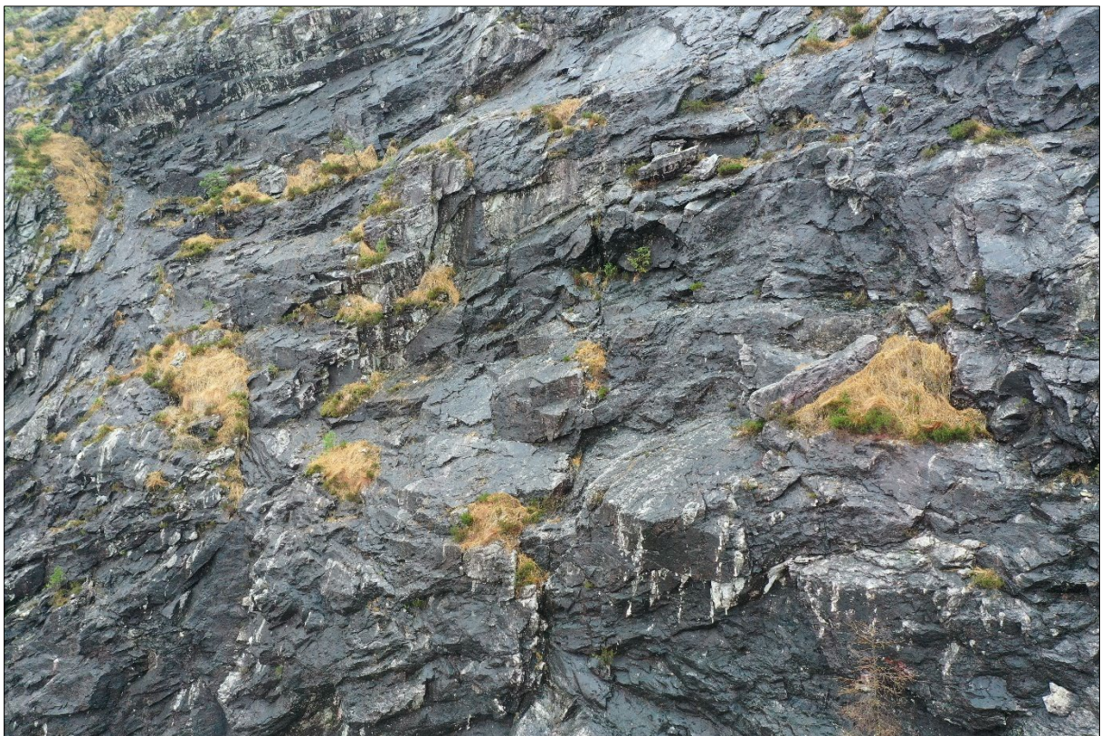
Figur 26: Nærbilete av fjellskråninga som viser delvis eller heilt avløyste blokker, typisk under 100 kg.
