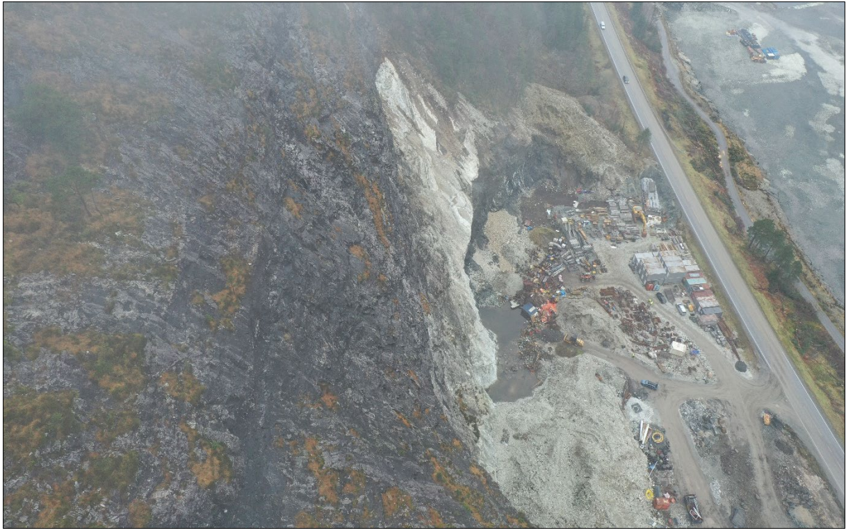
Figur 25: Dronebiletet av kartleggingsområdet og fjellskråninga. Planlagt kontorbygg skal plasserast ved konteinarane/brakkene som er står langs rv. 5 til høgre i biletet. Biletet er tatt mot vest.
