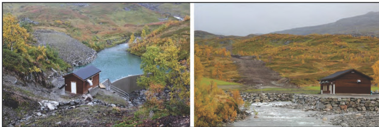
Figur 2: Grøndalselva kraftverk ble igangsatt i 2021. Kraftverket utnytter et fall på 124 m. Foto 2023.
