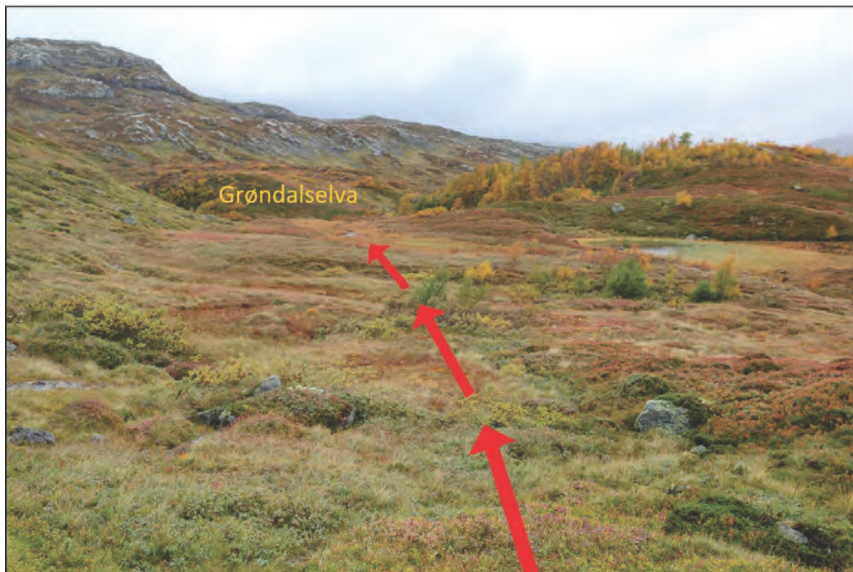
Figur 9: Foto mot vest: Det skal etableres grøft/kanal (røde piler) fra sidebekk og fram til et naturlig bekkeløp som drenerer videre mot Grøndalselva i vest, se også figur 7 og figur 10-12. Løsmassene er dominert av morene, som lengst mot vest er overdekket av grunn torv og myr.
