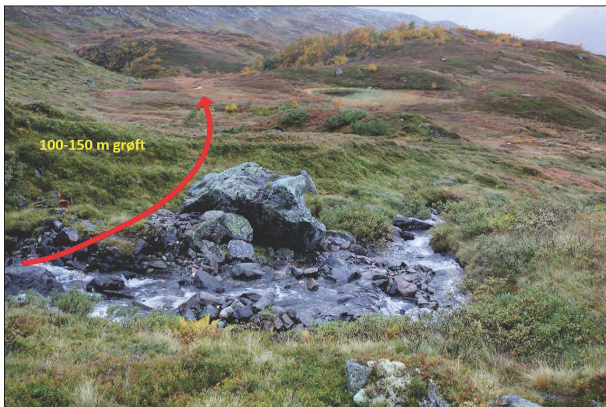
Figur 7: Vannet i sidebekk skal overføres til Grøndalselva kraftverk. Inntaket vil muligens ligge litt høyere enn ca. kote 925, som er vist her. Det skal etableres en 100-150 m lang grøft/kanal (rød pil) fram til et naturlig bekkeløp som drenerer videre mot vest, til inntaksdammen til Grøndalselva kraftverk.
