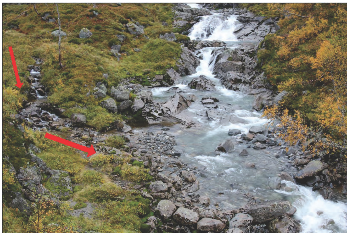
Figur 27: Den vestlige grenen av bekkeløpet som blir fraført vann (røde piler), se figur 26, renner inn i Grøndalselva om lag kote 781. Restvannføringen i Grøndalselva er stor på tidspunktet dette bildet ble tatt 28. september 2023. Overføring av bekkeløpet vil gi mindre vannføring i bekken til venstre, og tilsvarende mindre restvannføring i Grøndalselva nedstrøms ca. kote 781.
