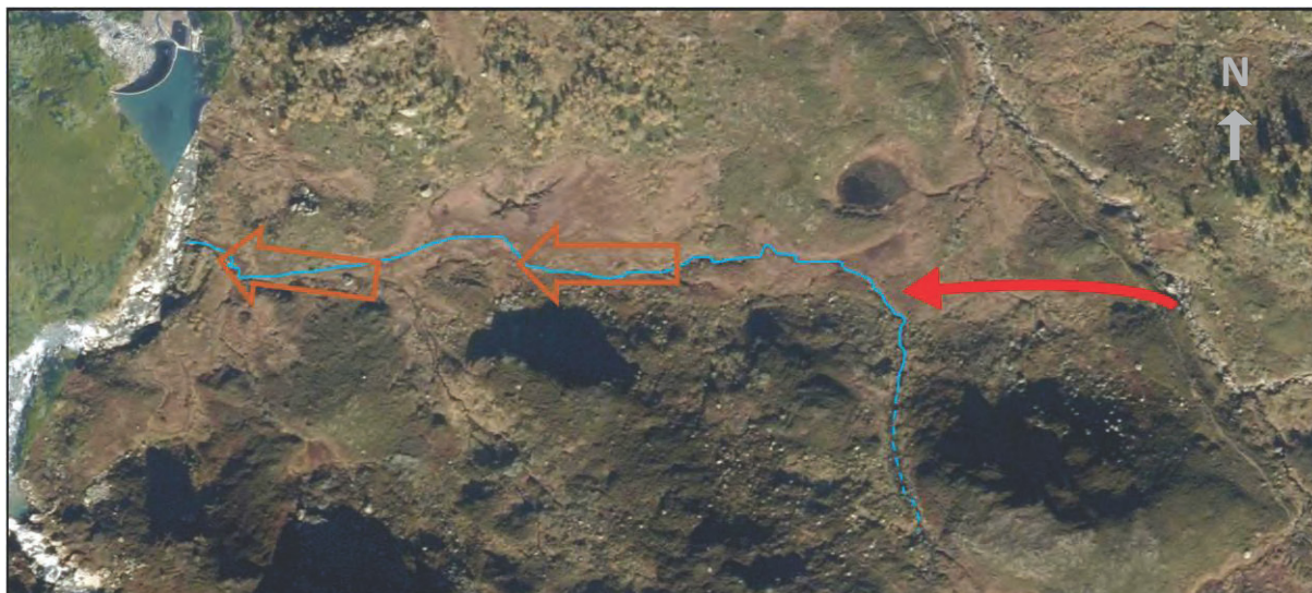
Figur 11: Tiltaksområdet vist på flyfoto fra 2019 (merk: Vestre utsnitt - lengst til venstre - er flyfoto fra 2022, hvor deler av nyetablert inntaksdam til Grøndalselva kraftverk er vist). Rød pil angir omtrentlig trasé for ny grøft/kanal fram til eksisterende vannvei (lyseblå strek). Grunnlag: https://kart.1881.no .
