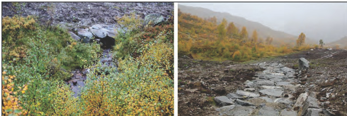
Figur 20: Bekkeløpet i øst, som vil få redusert vannføring, deler seg i to ved kote 865. Om lag kote 845 krysser den vestligste grenen nedgravd rørgate mot kraftstasjonen i eget rør (til venstre). Ny terrengoverflate i dette kryssområdet er steinsatt (til høyre).
