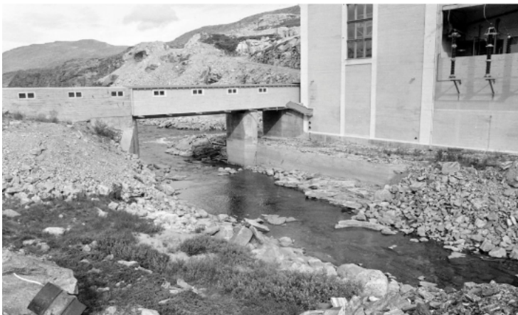
Osbu kraftstasjon, foto: NVE
