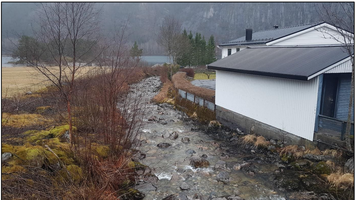
Figur 13: Oversiktsbilete teke frå brua langs rv.15. Elvebotnen består av grove blokker. Garasjen og elvestrekket forbi bustadhuset står på ein betongmur. Elles består begge elvesidene av grove blokker.
