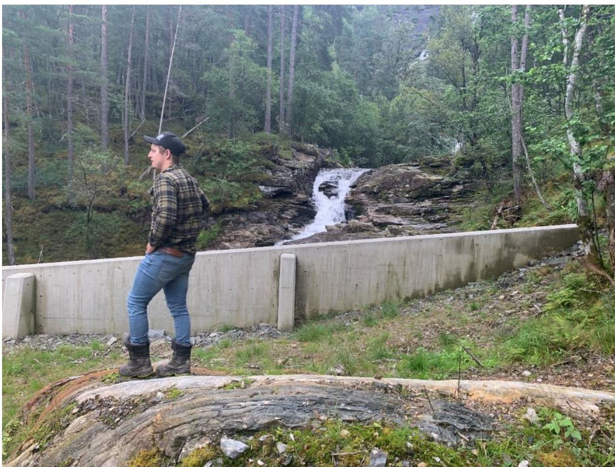
Figur 38 - Øvre flommur i overkant av planlagt kraftstasjonstomt. Flommuren vil bli forsterket etter med nøyaktige beregninger ifm. en eventuell bygging.
