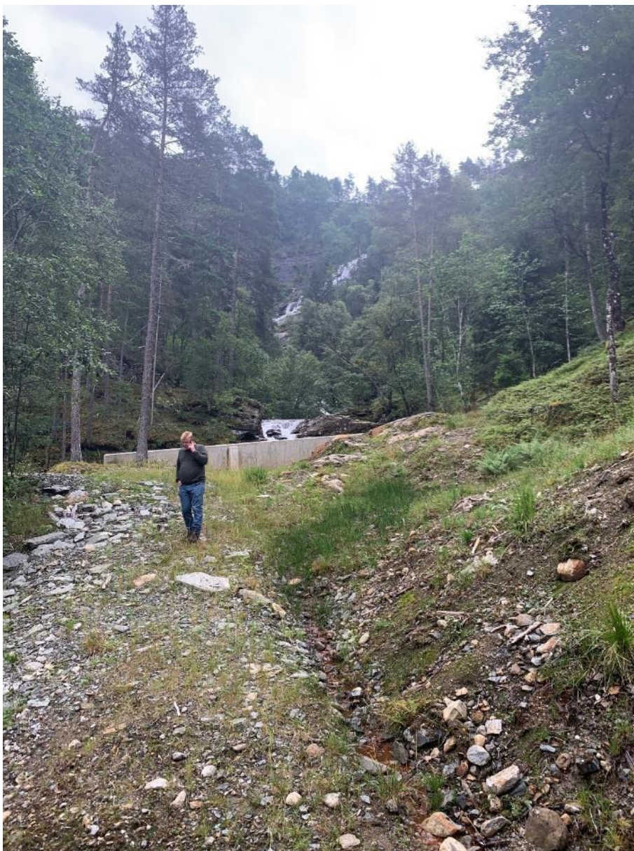
Figur 4 - Geitelvi med foss i bakgrunnen. Forebygging ved planlagt kraftstasjonsplassering sees midt i bildet
