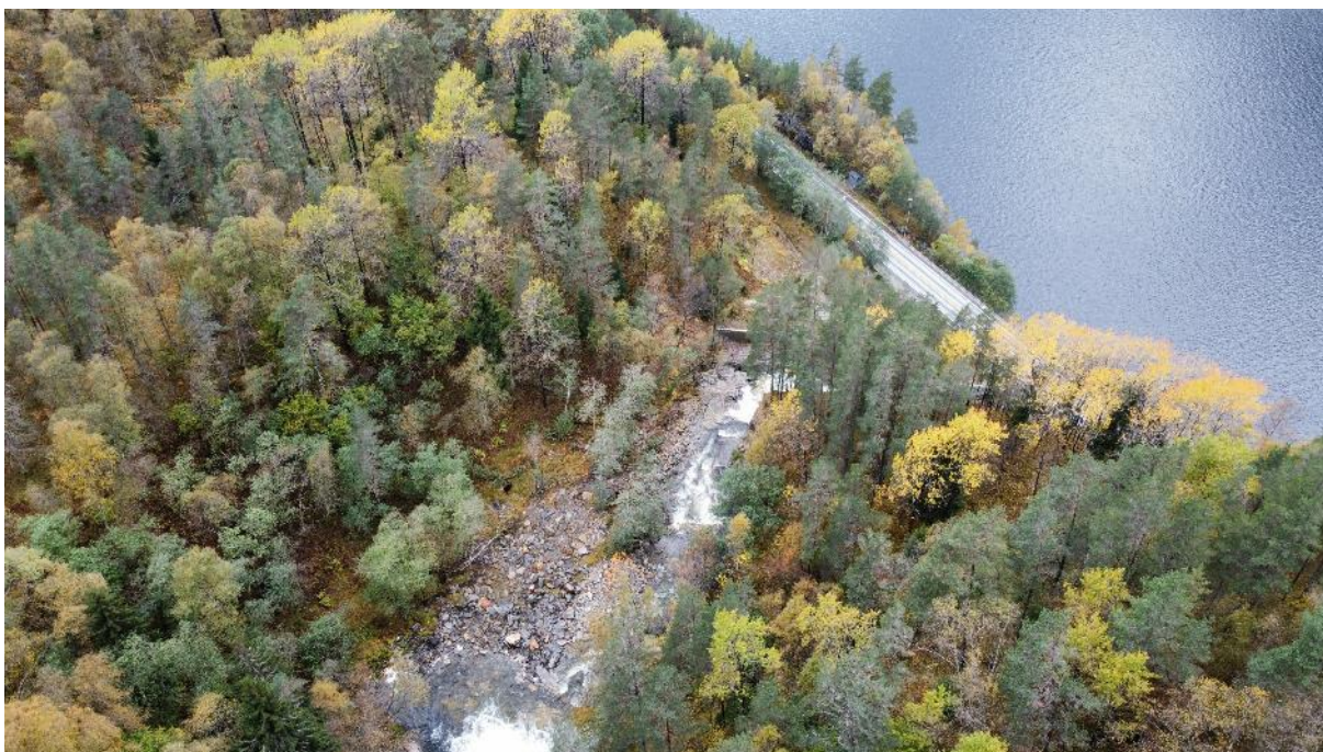
Figur 2 - Kraftstasjonsområde sett nedstrøms
