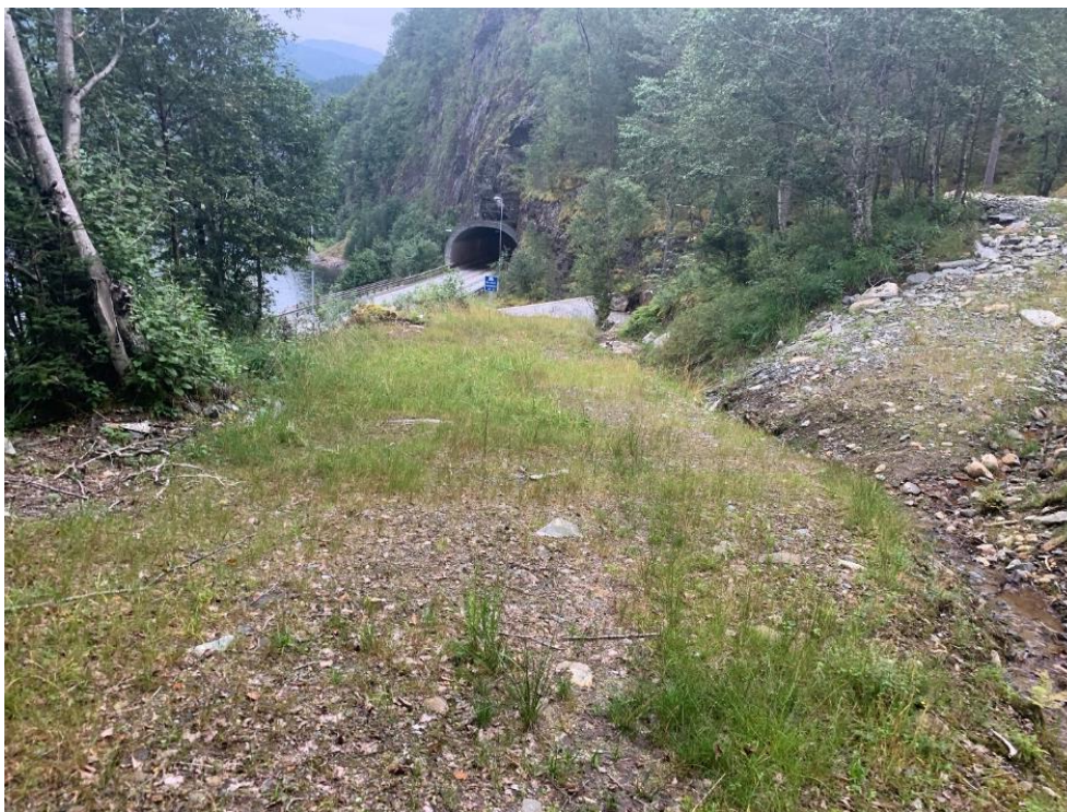
Figur 28 - Dagens vei i retning tunnel, samt stikkvei opp til kraftstasjonstomt. (opp til høyre i bildet). I enden av adkomstvei sees toppen av flomvern. (foto: Njord)
