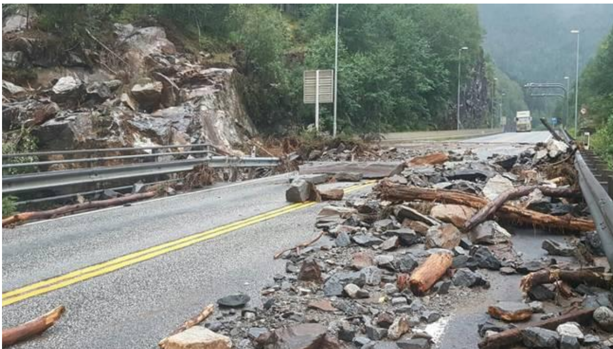
Figur 35 - Bro over Geitelvi på E16. (hentet fra www.nrk.no . Statens vegvesen har tatt bildene). Det blankskurte fjellet bak rekkverk i bildet er der det nå er støpt flommur og traktorveien går opp.
