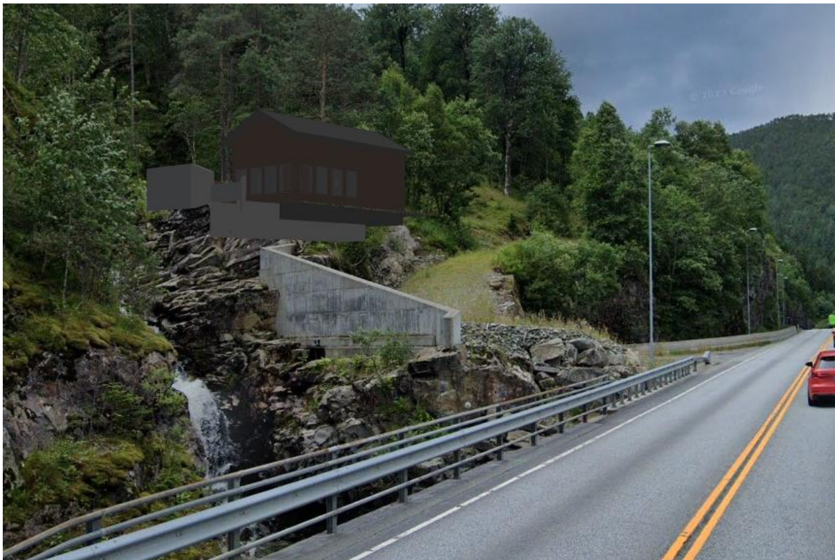
Figur 23: utklippsbilde fra google maps som viser samme motiv som figur over. Flomvern sees tydelig midt i bildet. Det er også er flomvern lenger opp ved kraftstasjon. Utløpskanal blir ført ut i nedre kant av øvre flomvern. Flomvernene blir tilpasset for å håndtere en 200 års flom forbi stasjonen.
