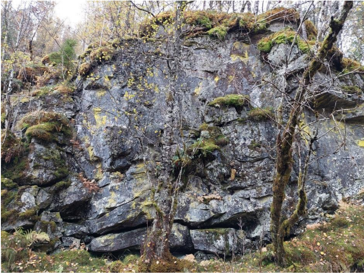
Figur 16 - Påhuggsted. En større bergvegg. Oppstart boring vil skje i denne.
