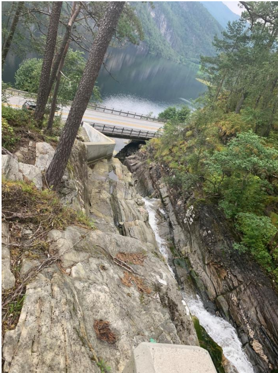
Figur 3 - Geitelvi sett fra Ca. kraftstasjonsplassering mot E16. Forbygning sees ovenfor bro på E16
