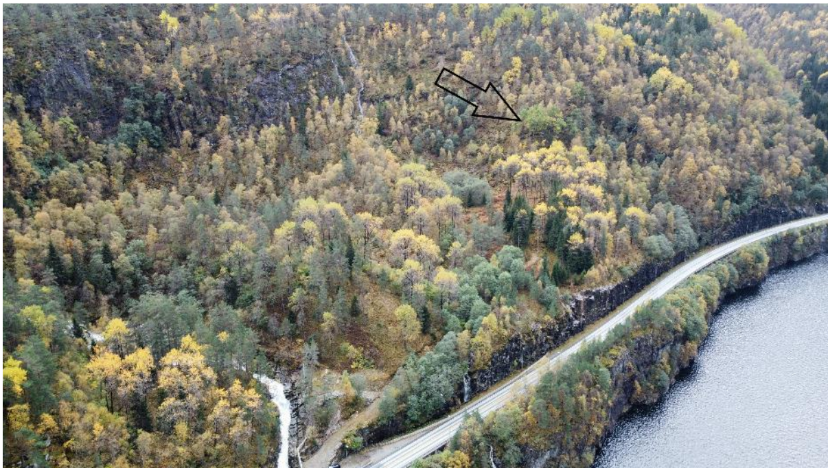
Figur 1 - Oversiktsbilde kraftstasjon. Pil angir påhugg
