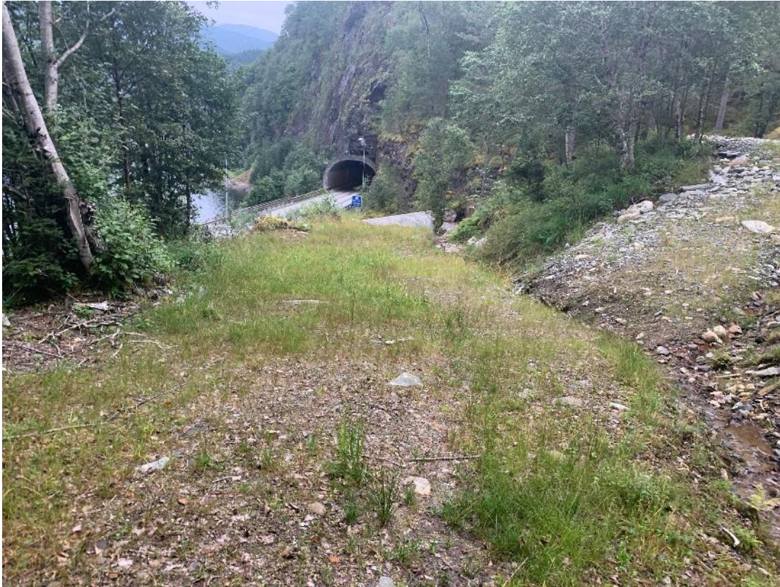
Figur 4 - anleggsvei opp mot kraftstasjon. Adkomst til kraftverk opp til høyre i bildet
