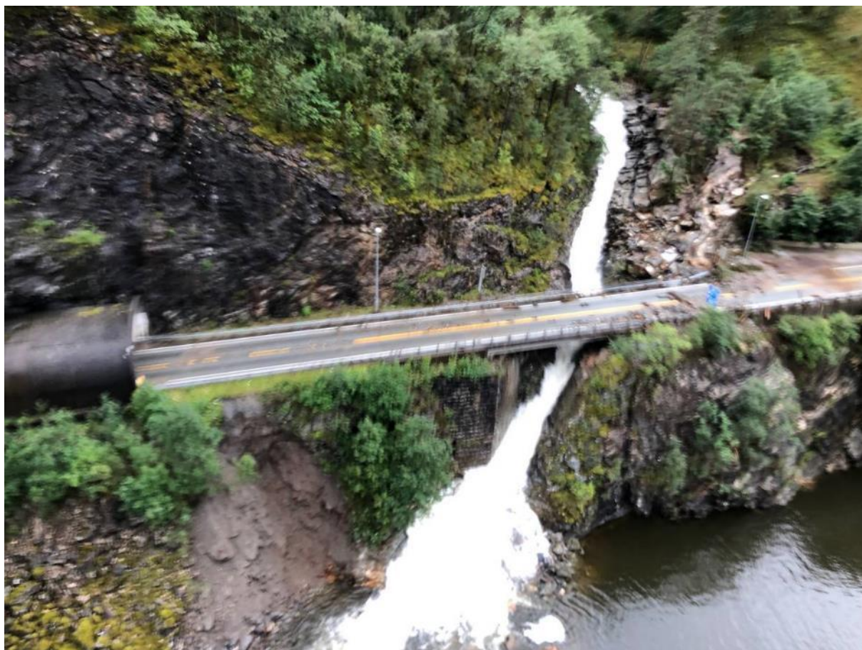
Figur 34 - Geitelvi sett fra Lufta ifm. ras i 2019. (hentet fra www.nrk.no . Statens vegvesen har tatt bildene). Kraftstasjon blir liggende øverst til høyre i bildet, området som her er dekket av skog.
