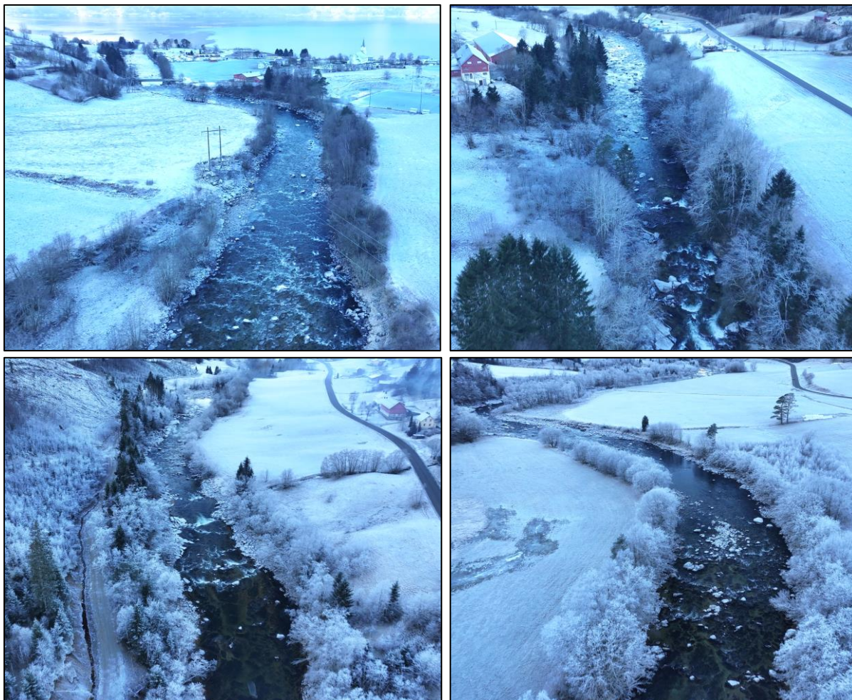
Figur 4-12: Visuelt inntrykk av vanndekket areal nedstrøms avløpstunnel (øverst til venstre), og tre lokaliteter på planlagt regulert strekning ved vannføring 1,9 m 3 /s + vannføring fra Myklebustdalselva (dronefoto 13.02.2025 av Kjetil Rolseth).
