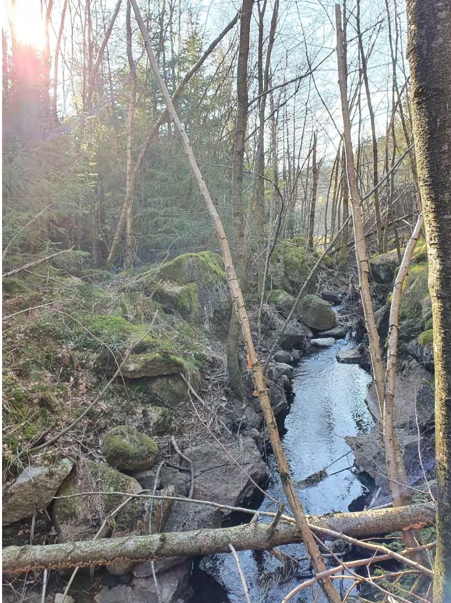
Figur 6-31. Kanalisert bekkeløp oppstrøms dam Moslandsvatn. Moslandsvatn i bakgrunnen.
