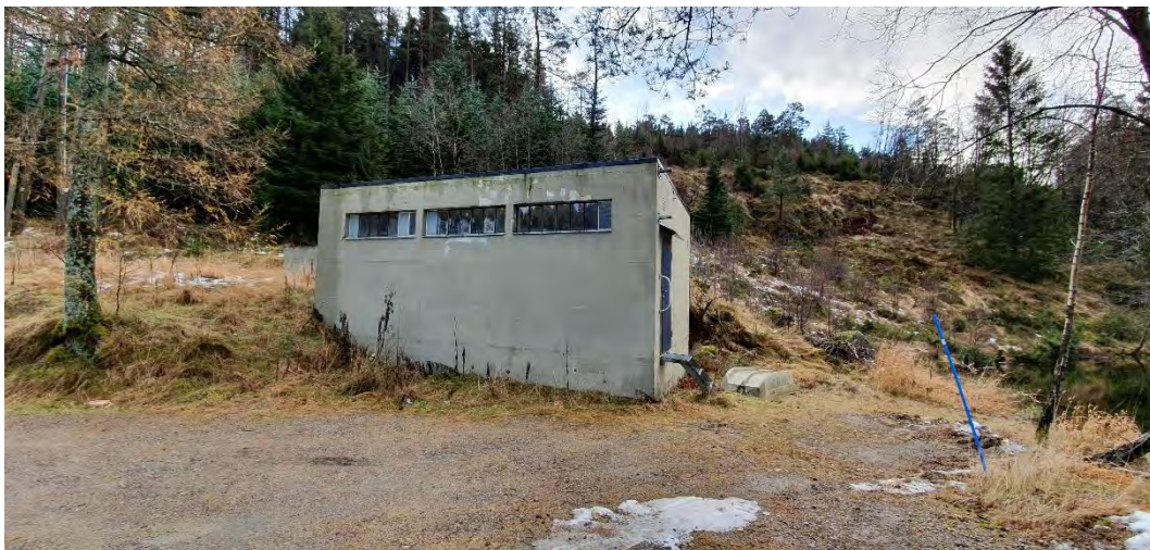
Figur 6-4. Dagens pumpestasjon ved Ommundsvatnet.
