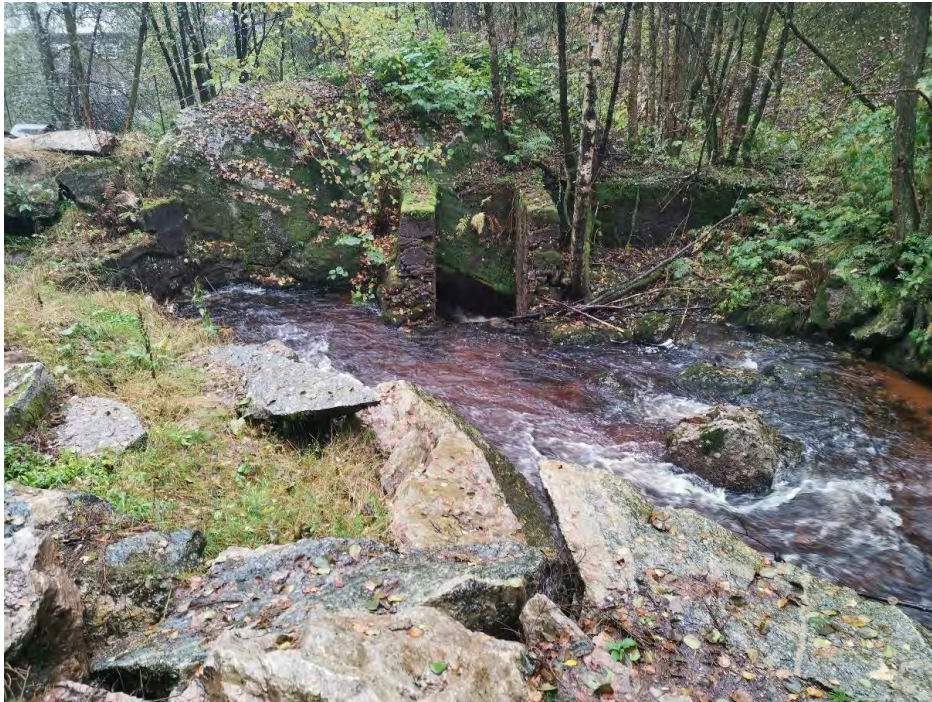
Figur 6-29. Moslandsbekken ved vandringshinder anadrom fisk. Gammel demning sees i bakgrunnen.
