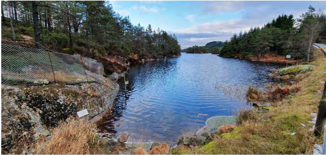
Figur 6-10. Møglandsveien går i fylling over søndre del av Møglandsvatn.
