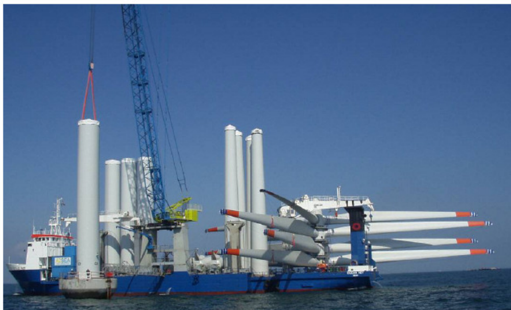
Figur 8: Vindmøller under installasjon, Nystedt, Danmark
