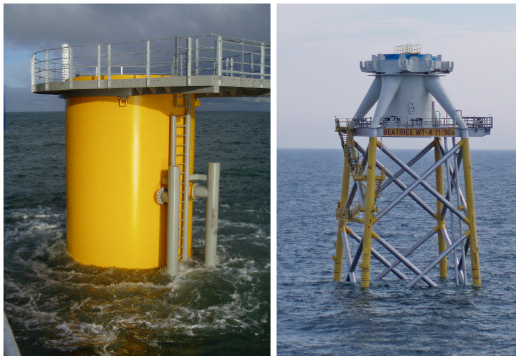
Figur 7: Monopel og jackets som fundament, kilde hhv Rambøll og Scaldis smc
