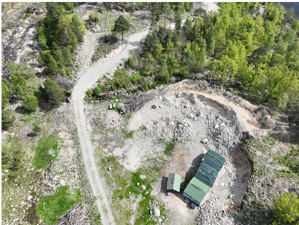
Figur 6-16 Y-kryss i adkomsten til Botnafossen kraftverk. Veien mot planlagt kraftstasjon tar av til høyre, mens kjerreveien opp til inntaksområdet følger traseen rett frem. Området er preget av enkel infrastruktur og lett tilgjengelighet for anleggsarbeid
