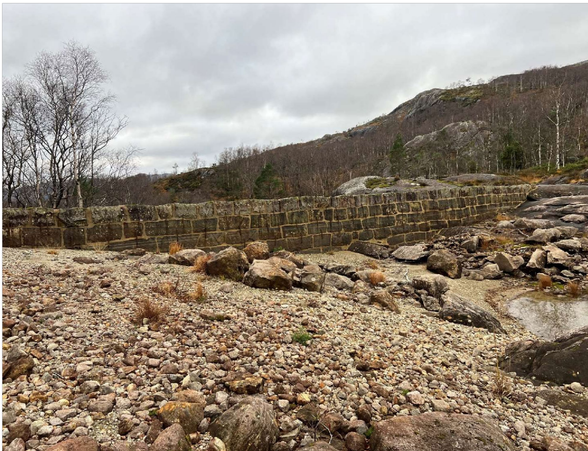
Figur 6-5 Inntaksdammen i Botnavatnet sett fra magasinet. Dammen skal rehabiliteres i eget, separat prosjekt.
