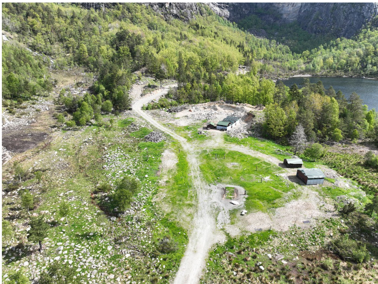
Figur 6-17 Oversiktsbilde fra ankomstområdet til Botnafossen kraftverk. Bildet viser eksisterende adkomstvei, nærliggende terreng og traseene videre mot kraftstasjonsområdet og inntaket
