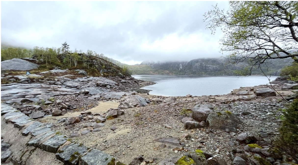
Figur 3-11 Botnavatnet sett fra dammen som ligger i den sørlige enden av magasinet.
