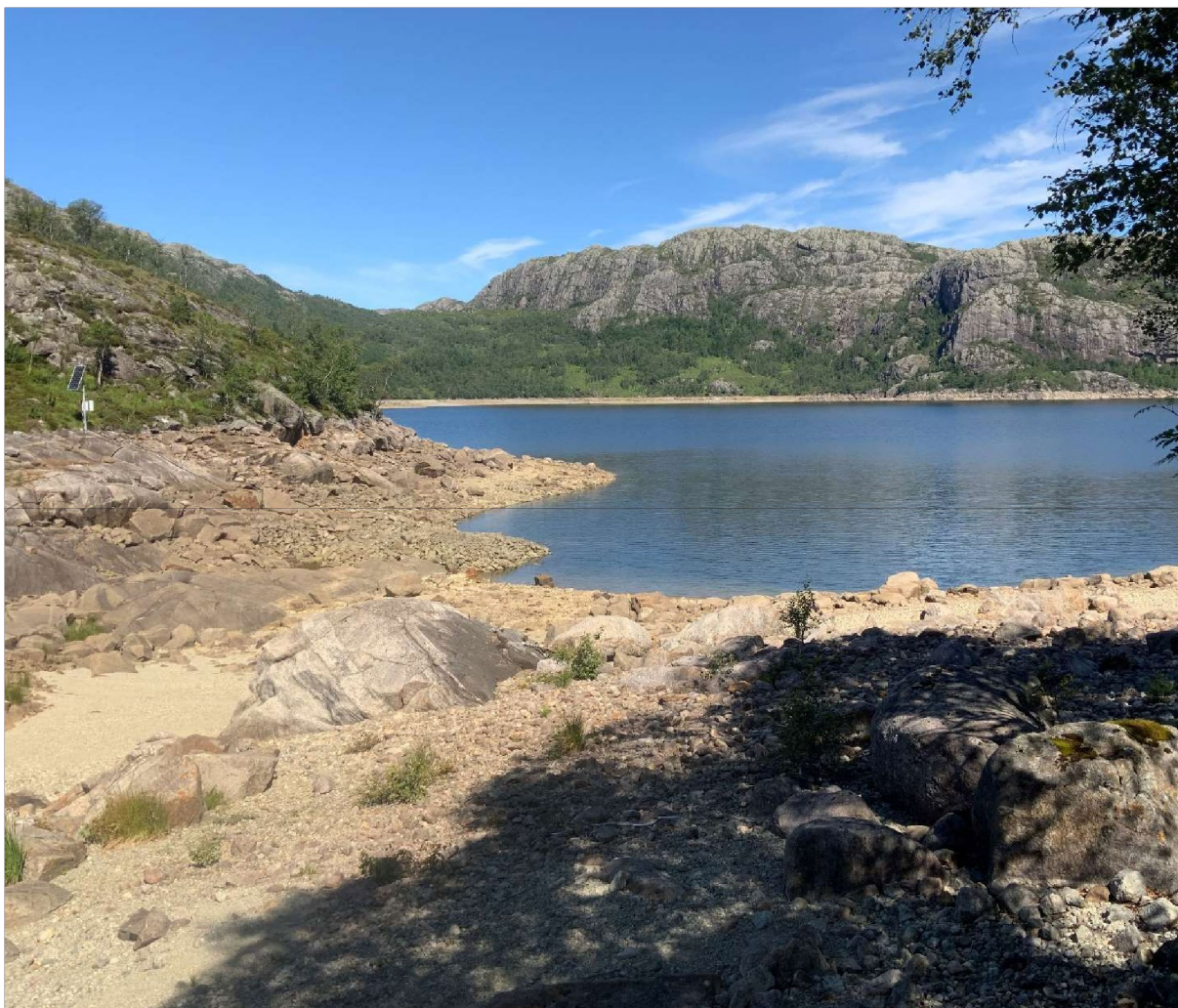
Figur 6-6 Inntaksområde. Innløp tappetunnel omtrent der solcellepanel står. Såle innløpstunnel er på ca. kote 706,15 (som er lik LRV, høydereferanse NN1954). Reguleringshøyde 8 meter. Reguleringsvolum 11 mill. m 3 .
