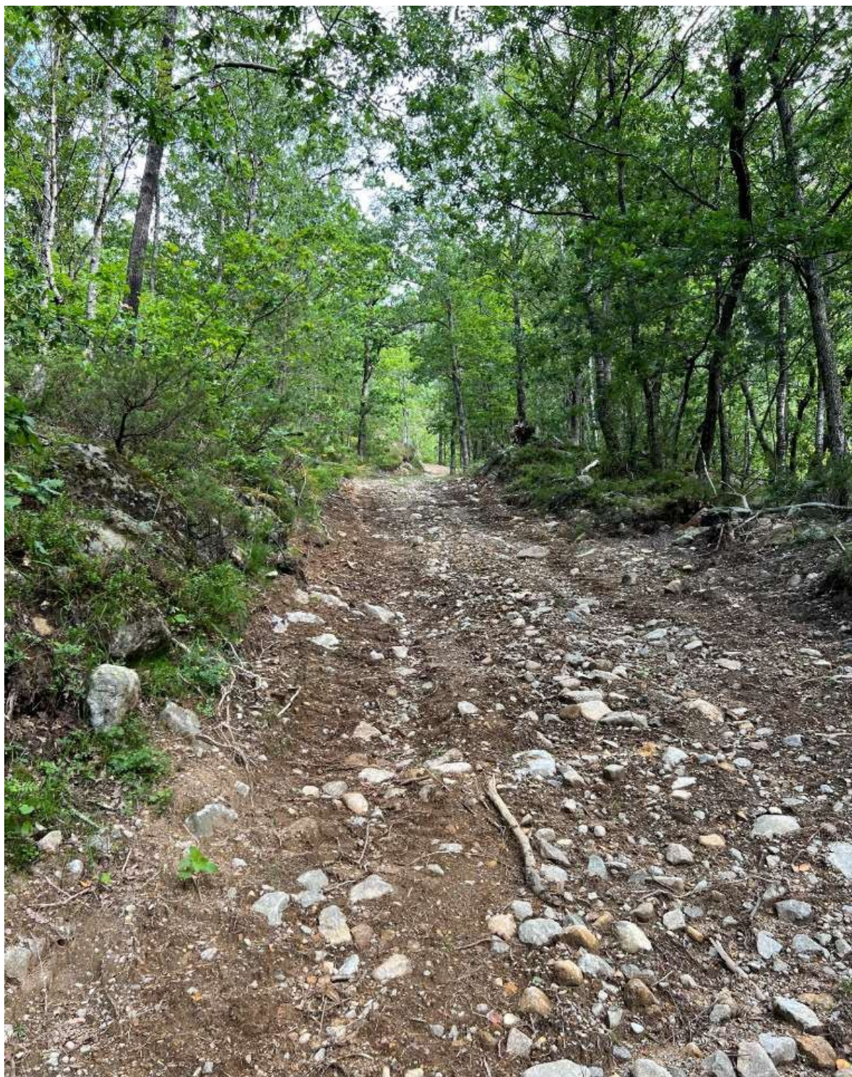
Figur 6-15 Dagens kjerreveg opp til dam/inntak. Rørgate vil gå delvis i denne og vil bli vasket bort ved et ev. stort rørbrudd.
