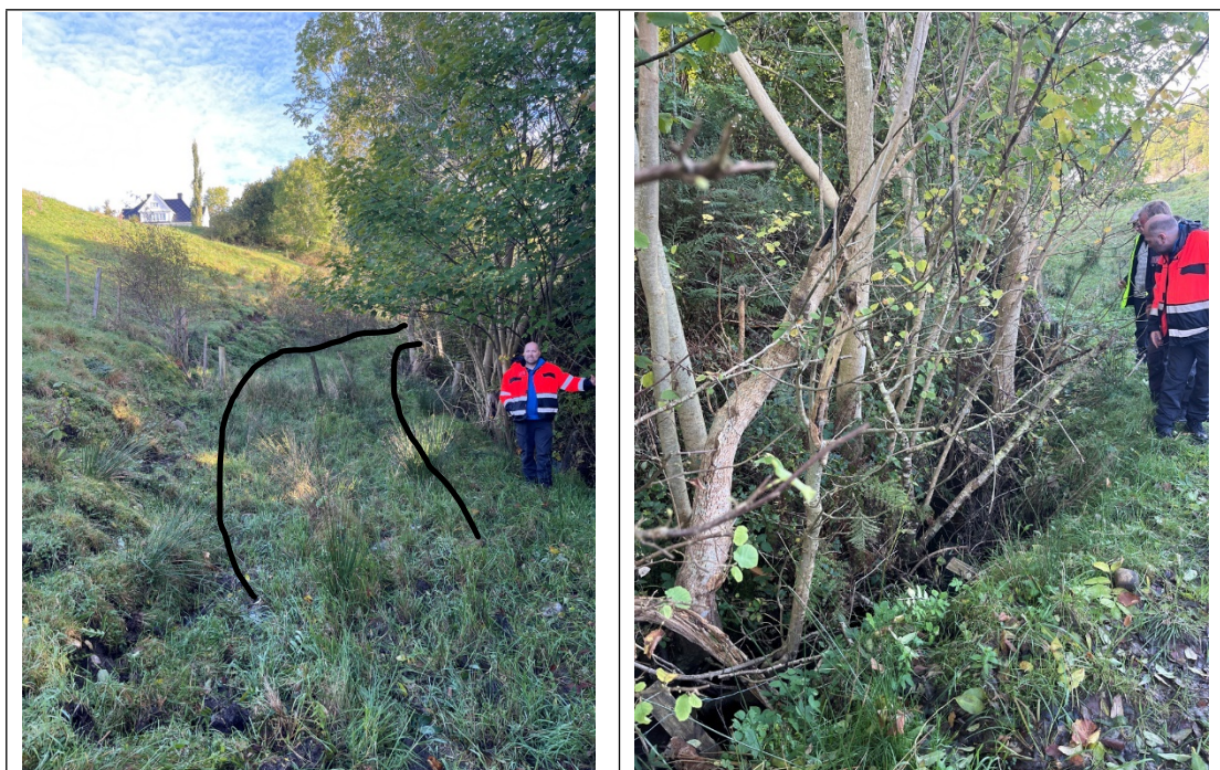
Figur 4 Eldre traktorveg langs bekk i skråninga nedanfor fjøset (punkt 4). Traktorvegen dannar eit forland mellom bekken og skråningsfoten. Det er ikkje erosjon inn mot traktorvegen pga. eldre steinforbygning i bekk.
