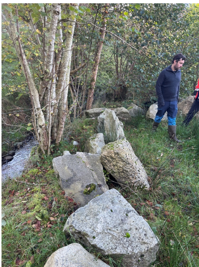
Figur 5 Grunneigar har lagt ut stor stein i bekkkant for å hindre erosjon (punkt 5)
