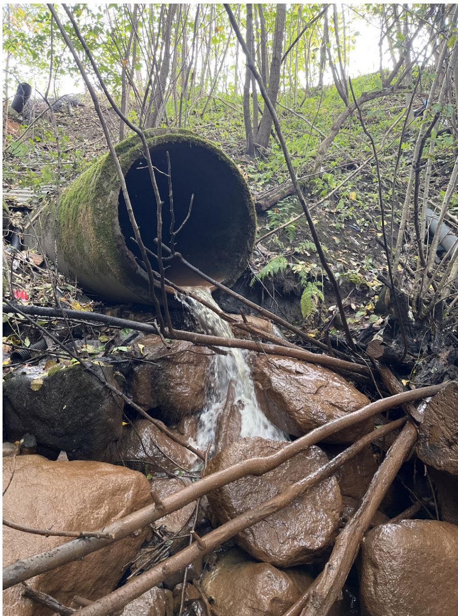
Figur 9 Kulvertutløpet ved punkt 7
