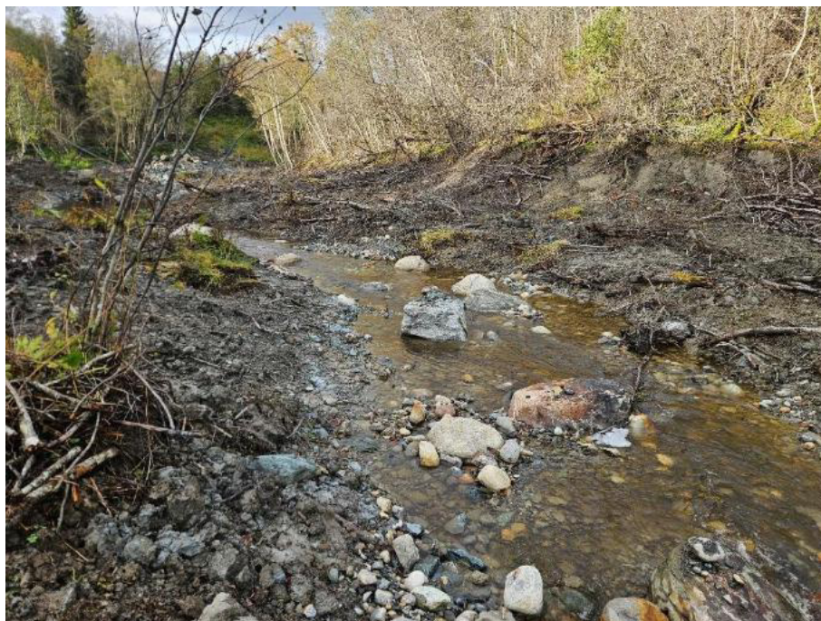
Figur 2-1: Bilde av ferdig anlegg med steingrupper. Stedegne masser er lagt tilbake for å revegetere. Legg merke til variasjon i bekkeløp. Foto: Multiconsult
