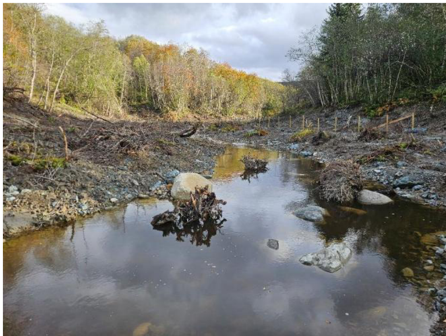
Figur 7-3: Bilde av et ferdig anlegg med en kulp med noen steingrupper og tømmerstokker/røtter som er festet i bunnen. Foto: Multiconsult.
