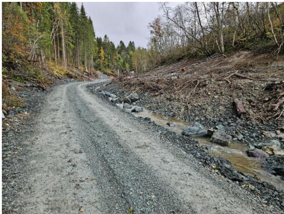
Figur 7-4: Eksempel på anleggsvei i ravine og midlertidig omlagt bekk i sikret grøft. Legg merke til steingruppene i elva som er med på å bremse vannhastighetene. Foto: Multiconsult
