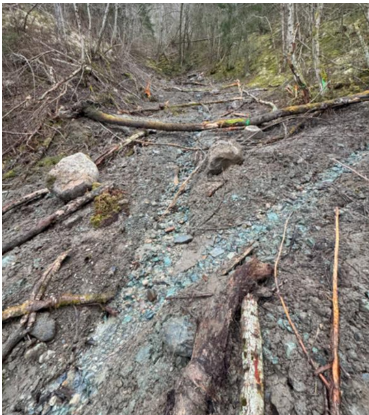
Figur 7-6: Eksempel på ferdig utført sikring og godt utlagt dødv ved. Foto: Multiconsult
