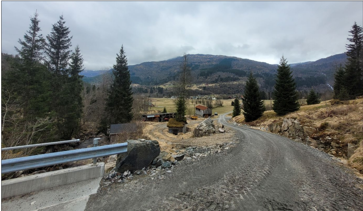
Figur 26: Området ved kritisk punkt hvor potensielle skred kan bryte elveløpet og flyte utover. Området er slakt hellende og eventuelle sørpeskred som sporer av vil ha begrenset hastighet (kap. 3.6). Infopunkt 4.
