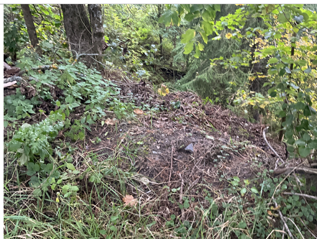
Bilde 14. Fylling ved skråningskanten (bør unngås)
