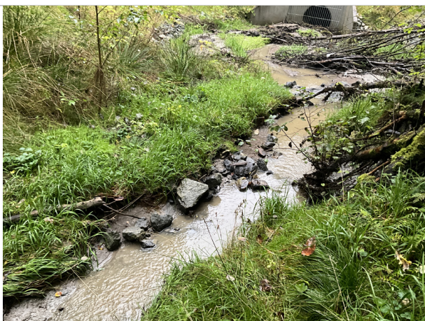
Bilde 9. Innløpet til kulverten er delvis plastret.
