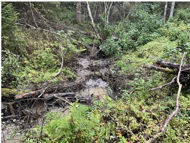
Bilde 5. Mye rot i bekken, som er delvis oppdemmet. Vannet eroderer og finner nye veier rundt trestammer og grener.
