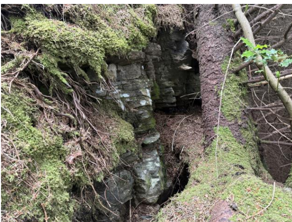
Figur 20. Skrent hvor oppsprekkingen i skrenter er preget av slakthellende fall innover i skrent.
