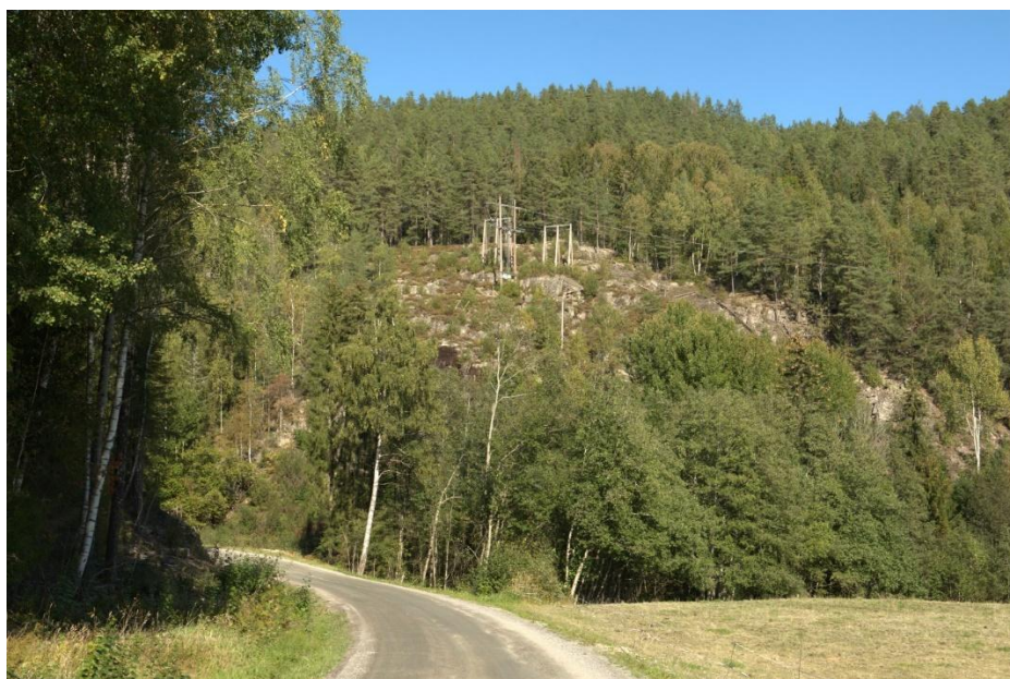
Figur 4-10. Eksisterende bryteranlegg ved Kåsa er godt synlig fra Vrangfossvegen
