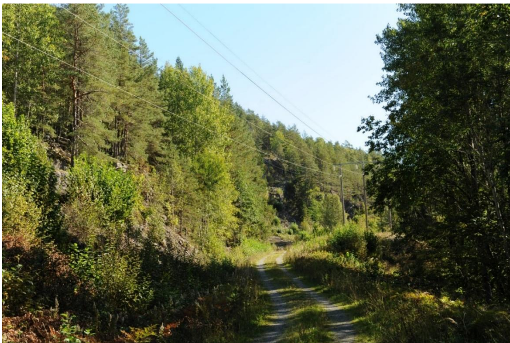
Figur 4-3. Eksisterende 66 kV ledning passerer Skaravegen ved flere steder, her er vegen avbildet i det man kommer opp fra Eidsfoss sluser. Her vil ny trasé gå lenger inn i skogholdet til venstre på bildet, slik at den blir mindre synlig fra vegen.
