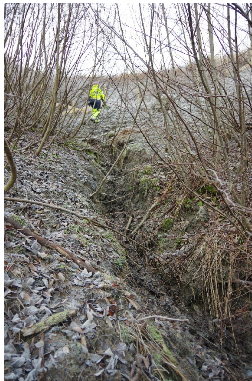
Figur 7 Grøft ved nytt bekkeløp oppstrøms
