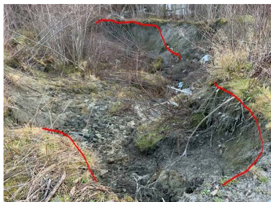
Figur 10 Status ved 2019 skred
