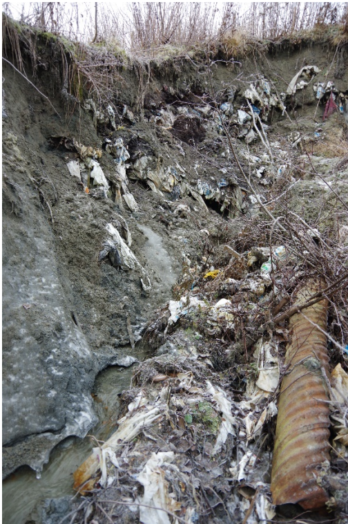
Figur 4 Skredbakkant, søppel har raset ned
