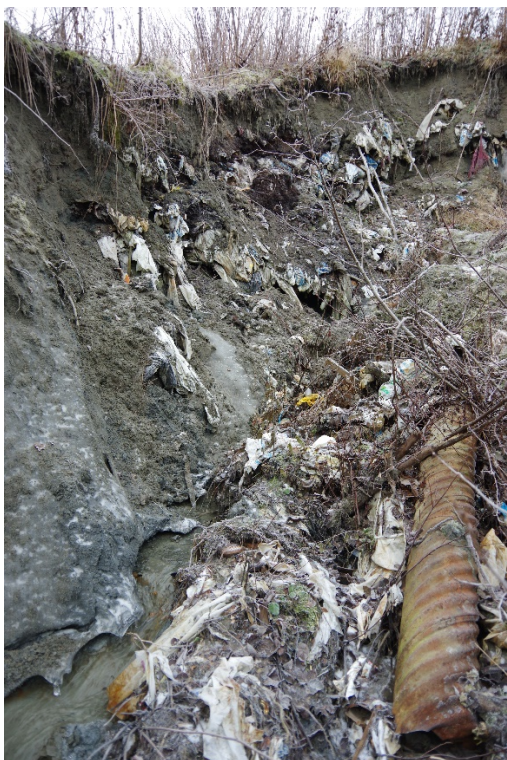
Figur 4 Skredbakkant, søppel har raset ned
