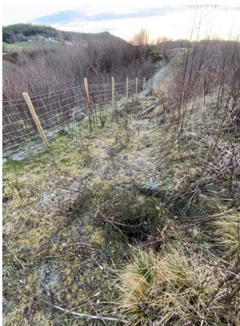
Figur 12 Status ved tidligere skred
