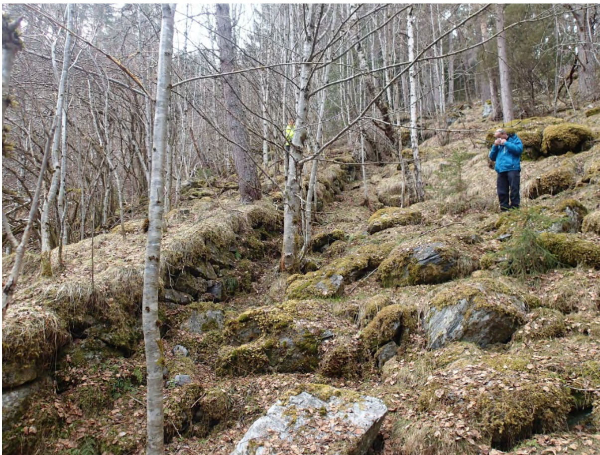
Figur 4. Bilete som viser den oppmura rørgatetraseen knytt til gamle Døsen kraftverk, ved om lag pel 300 (sjå figur over). Referanse: kommentarar til høyringsfråsegn (202115667-21).
