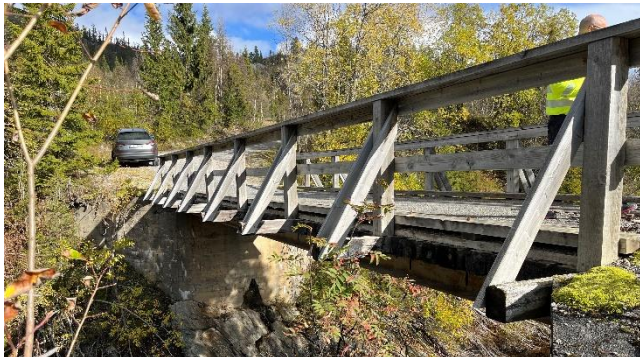
Figur 3-6. Bro som vil kreve tiltak før anleggstrafikk.
