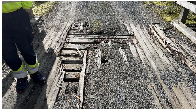
Figur 3-7. Tilstand på bro som krever tiltak.
