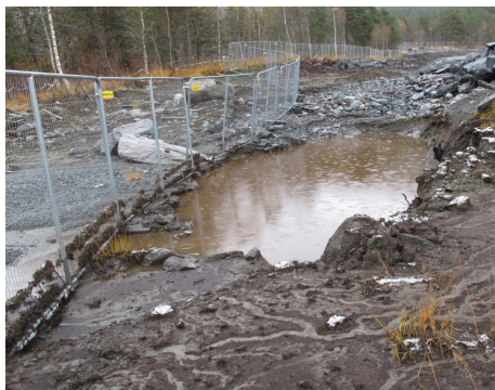
Figur 44: Enkelt sedimentasjonsbasseng for oppsamling av sand og gruspartikler. Viktig at de blir tømt regelmessig, for å oppretholde funksjonen.
