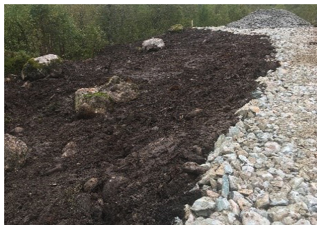
Figur 38: Istandsatt sideterreng i tråd med veilederen fra landbruksdirektoratet, "Skogsbilvegbygging med miljøhensyn".
