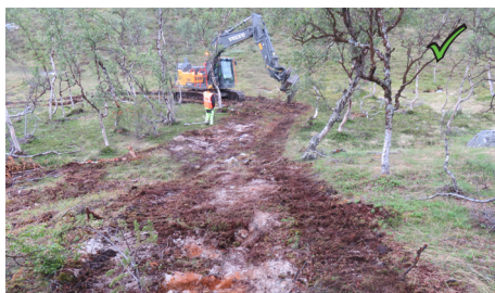
Figur 34: Ved uttransportering av maskiner og utstyr, skal kjørespor legges i gjenn og pusses. Gjenlagte spor skal ikke på nytt benyttes uten avklaring med Statnett
