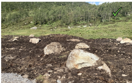
Figur 30: Naturstein som en del av tilbakefylling. Steinen er nedsenket i massene, slik at det fylles rundt basis.
