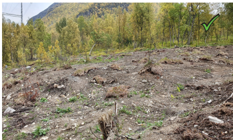
Figur 27: Istandsatt trommeplass der tuer med vegetasjon er plassert ut. Dette gjør at revegeteringen går raskere.
