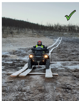
Figur 10: Eksempel på etablert terrengforsterkning over bløte partier.
