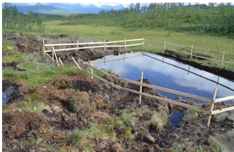
Figur 41: Etablert sedimentasjonsbasseng for håndtering av vann fra byggegrøp for mastepunkt. Bassenget fylles igjen etter bruk.
