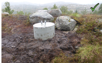
Figur 20: God overgang mellom stabbe og terreng.
