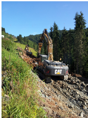
Figur 37: Opprusting av landbruksveg med stedege masser.
