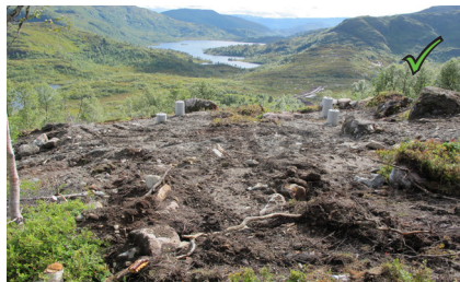
Figur 18: Godt tilbakeført fundament. Overgang mellom fundament og omliggende terreng er ivarettatt på en naturlig måte. Overflaten er rufsete og godt tilrettelagt for naturlig revegetering.
