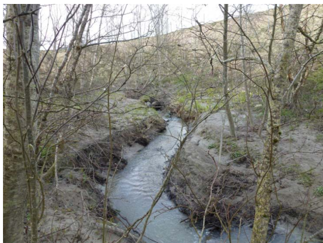
Bilde 512 Kulvertinnløpet ved Engan
