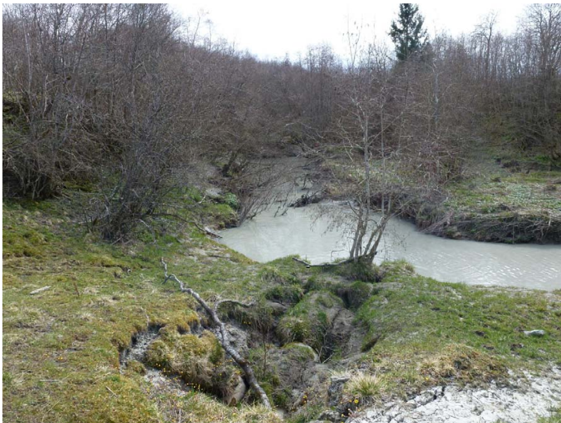
Bilde 589 Ved utløpet i Ristbekken , ødelagt drens har medført kraftig utvasking
