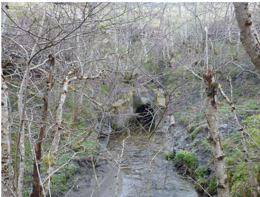
Bilde 418 Brenselbekken, kulvertinnløpet under vegen til gården Rønningen
