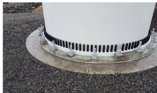
Figur 3 - sammenligning av gravitasjonsfundament og fjellforankret fundament etter at anlegget er klargjort for turbinmontering.
