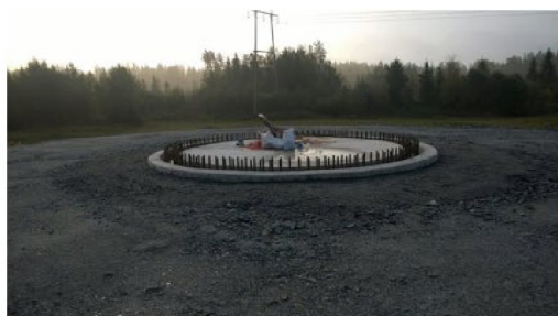
Figur 3 - sammenligning av gravitasjonsfundament og fjellforankret fundament etter at anlegget er klargjort for turbinmontering.
