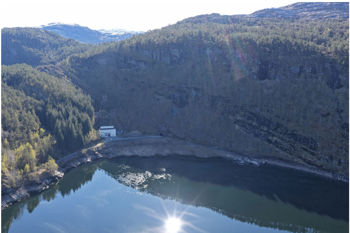
Figur 11 Grønsdalsvatnet nord, ved Grønsdal kraftverk, rett etter anleggsperiode/deponering. Vannstand +189 (1 m over LRV).
