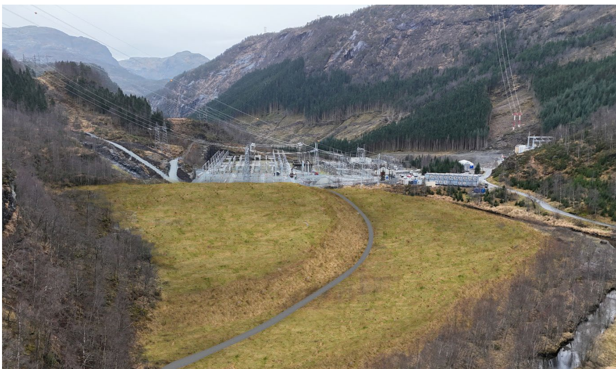
Figur4 Deponiområdet i Børdalen etter oppfylling sett ovenfra.
