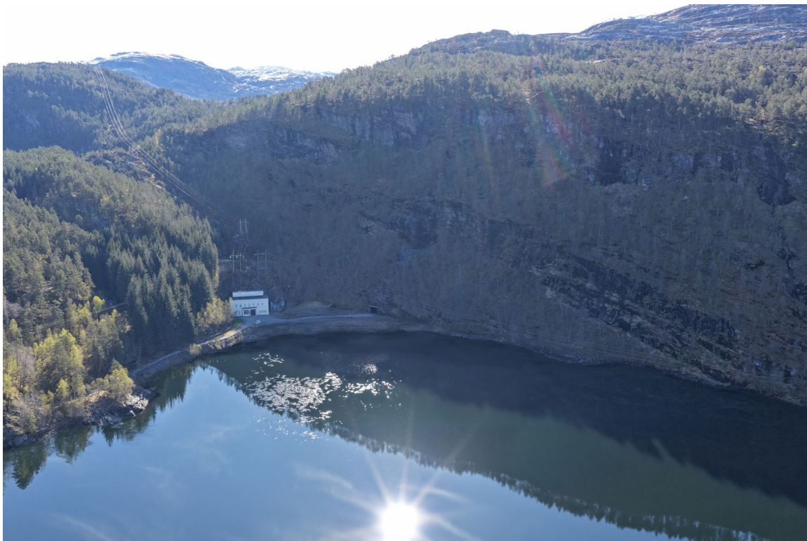
Figur 12 Grønsdalsvatnet nord, ved Grønsdal kraftverk, rett etter anleggsperiode/deponering. Vannstand ved HRV +198.
