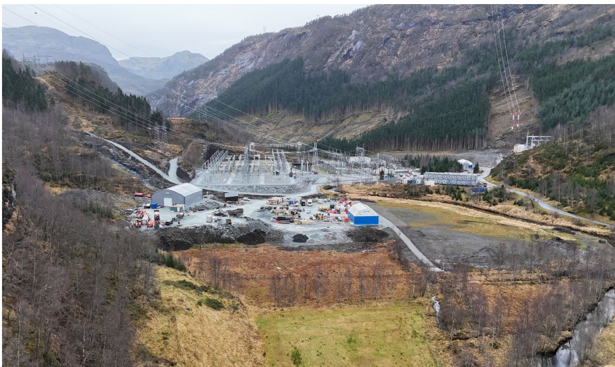
Figur 3 Børdalen sett ovenfra før deponering.
