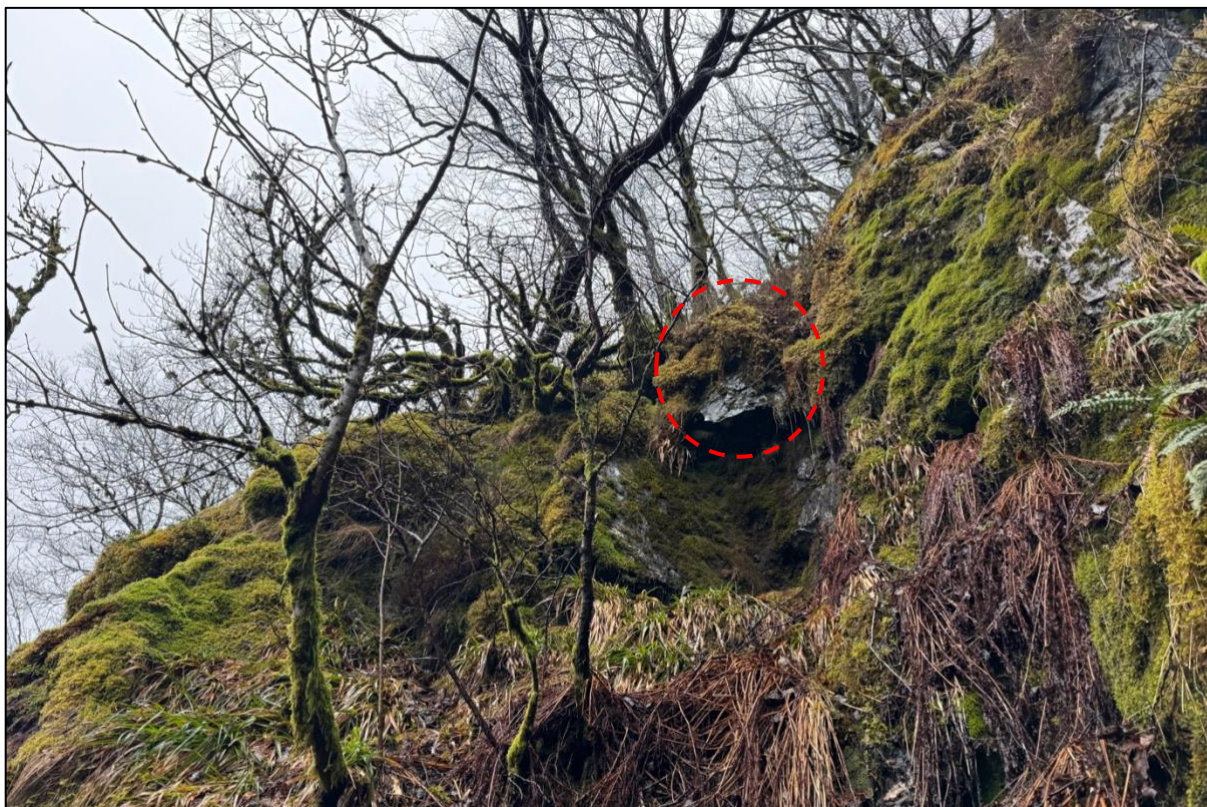
Figur 6: Bergskrent ca. 50 m nord for kartleggingsområdet med en tilsynelatende avløst og dels overhengende blokk (rødt) som er delvis skjult under mose.
