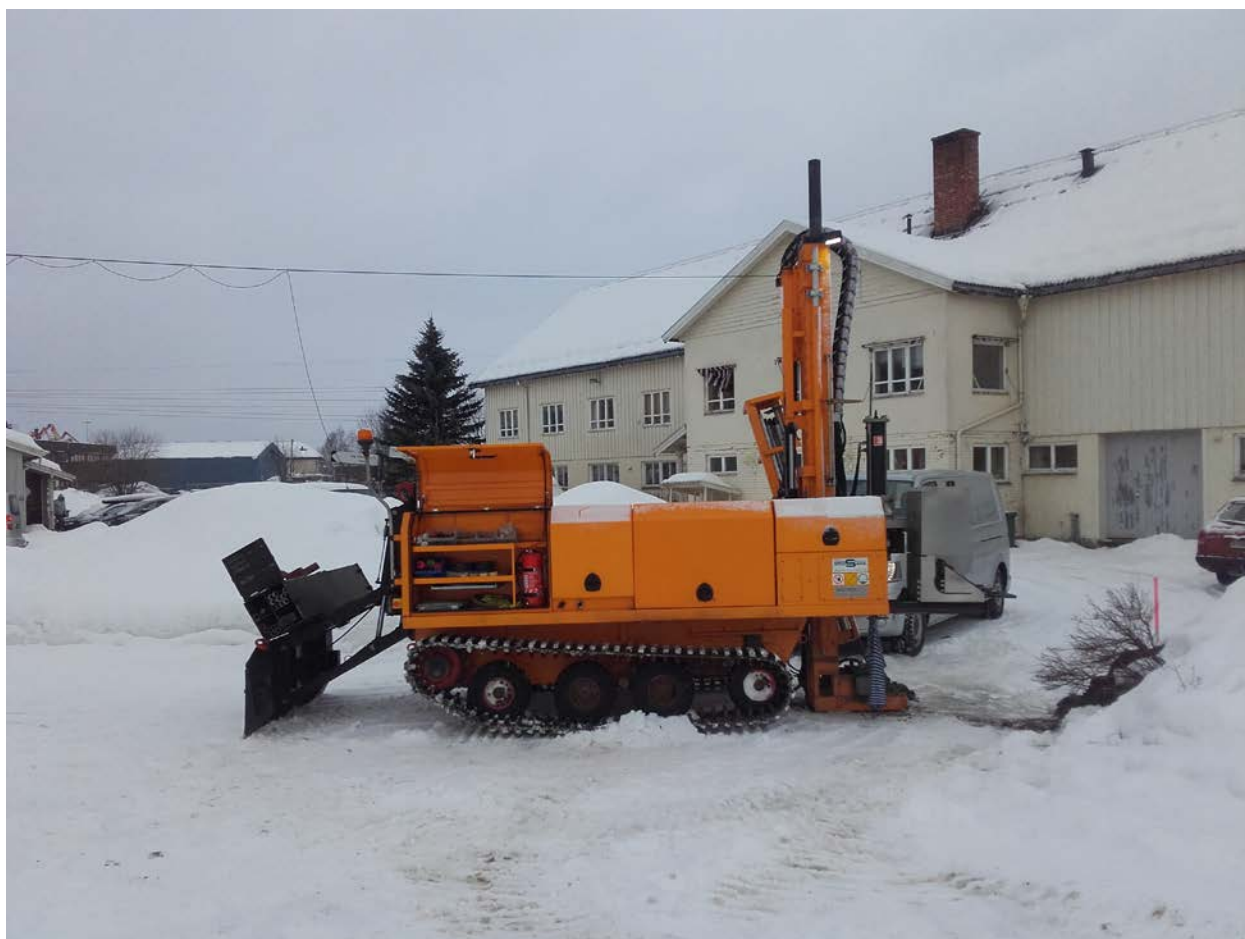
Bilde av borerigg tatt under feltundersøkelsene
