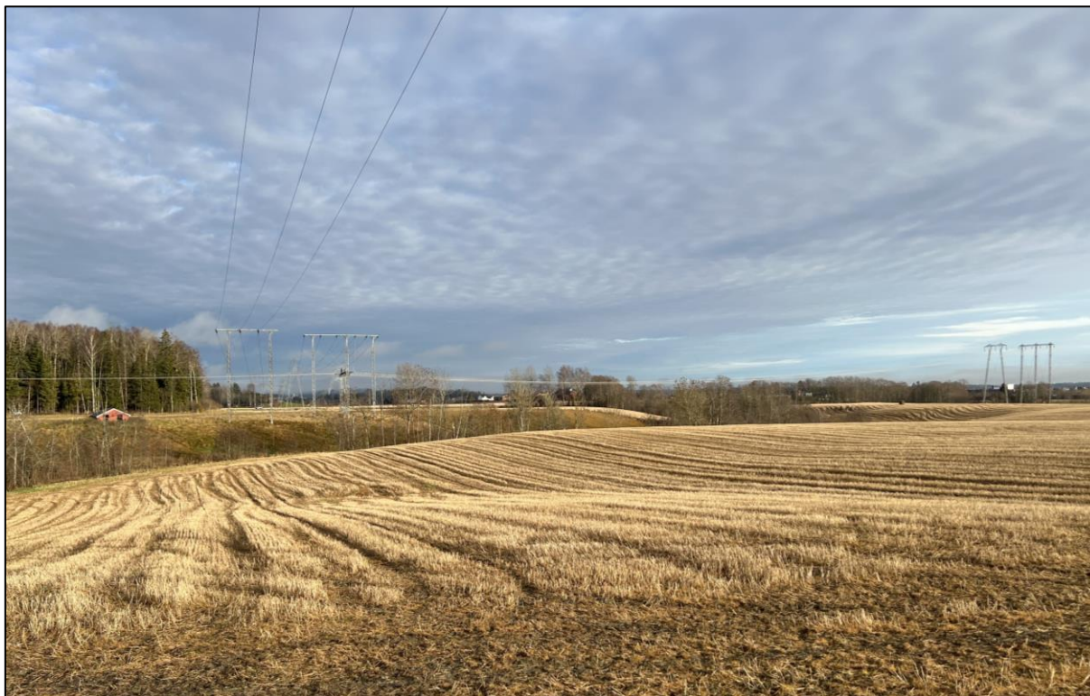
Figur 3-5: Utsikt nord-nordøst fra Åmodt nedre sør i tiltaksområdet, mot eksisterende master og linjer.
