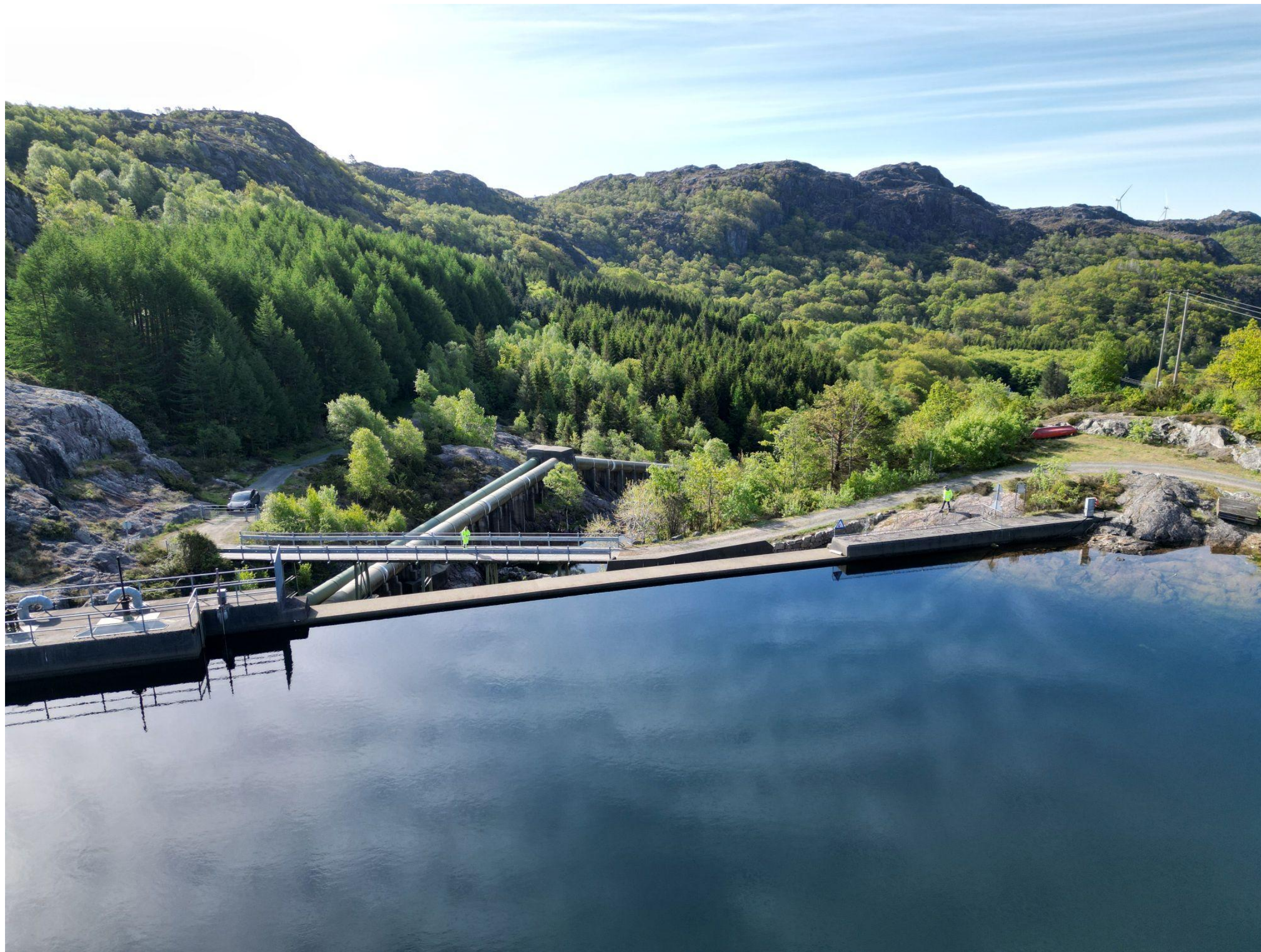
Bilete som viser eksisterande dam og inntakskonstruksjon frå oppstraums side.
