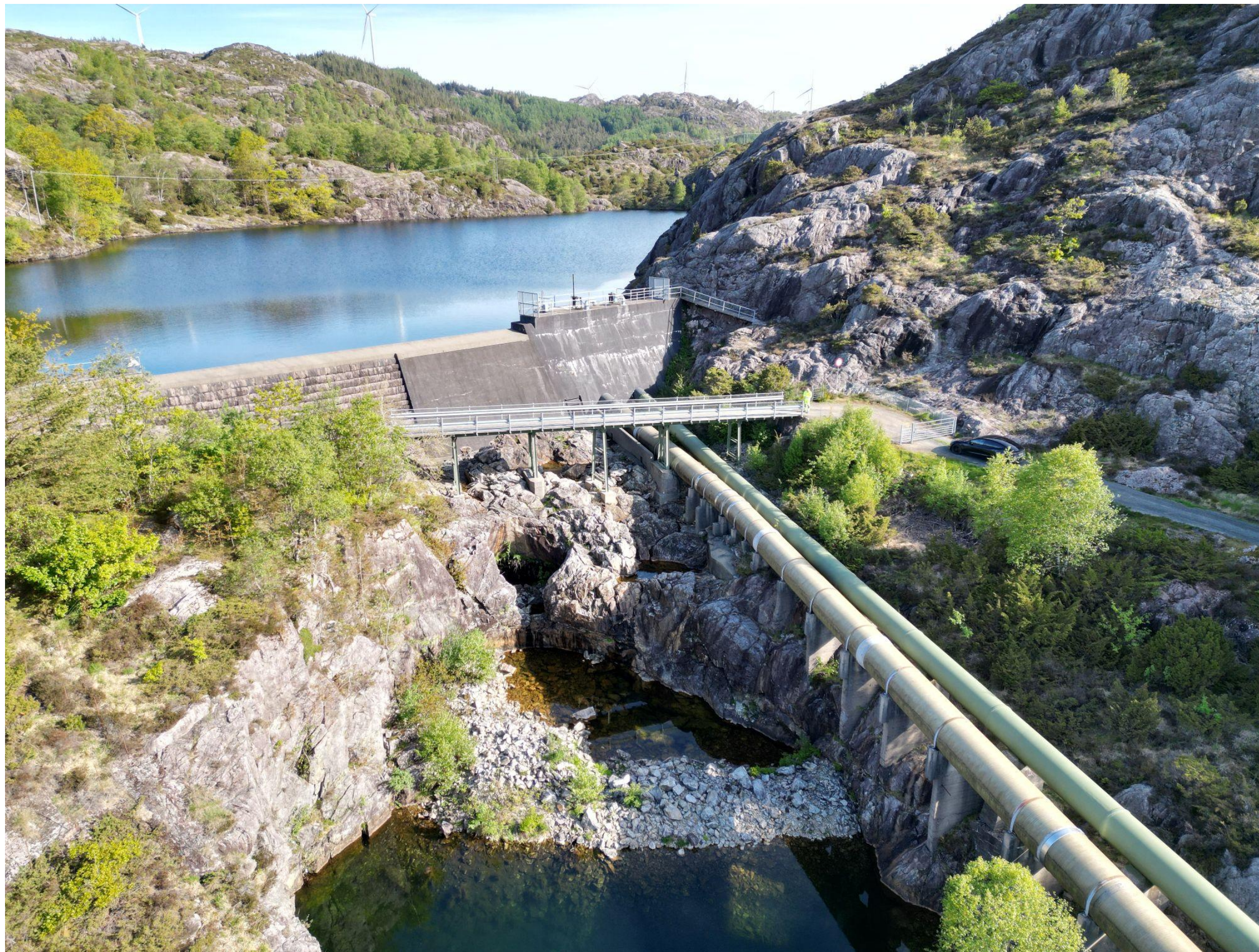
Bilete som viser eksisterande dam og trykkrøyr frå nedstraums side dam.
