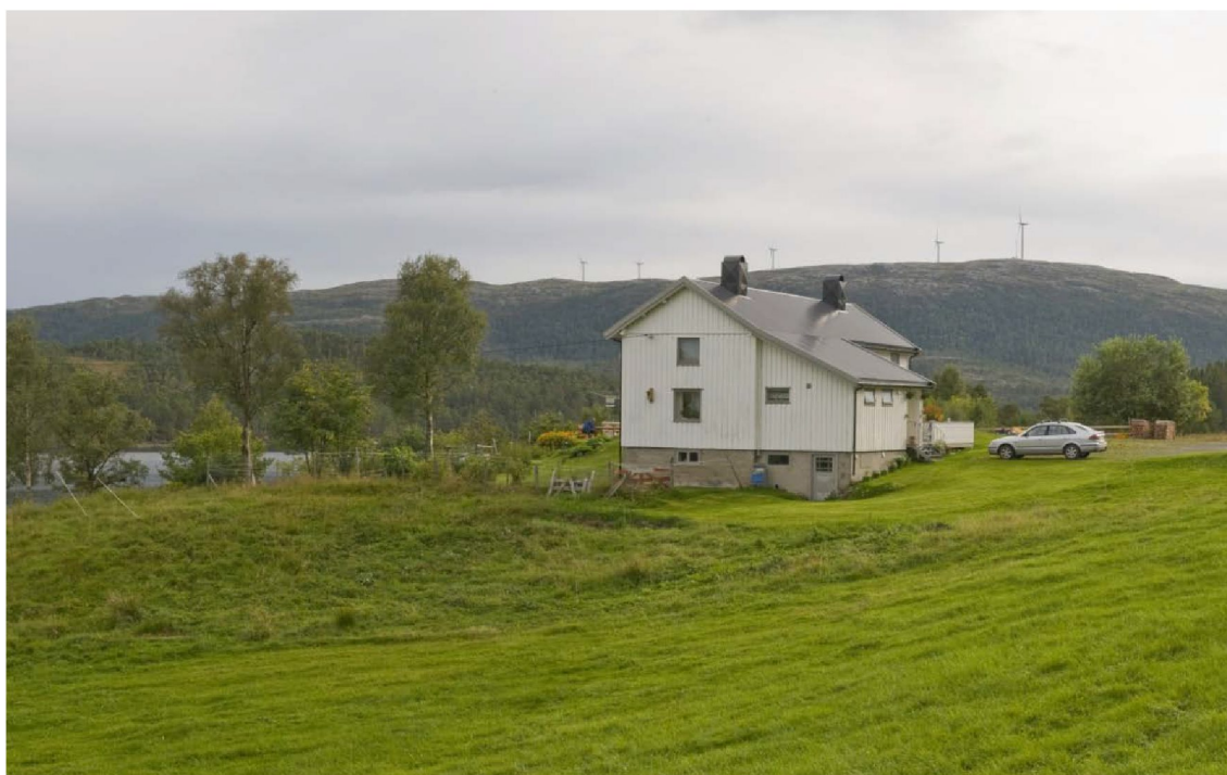
Figur 29: Hitra vindpark, dagens situasjon sett fra Søraunet. Foto: Einar Berg
