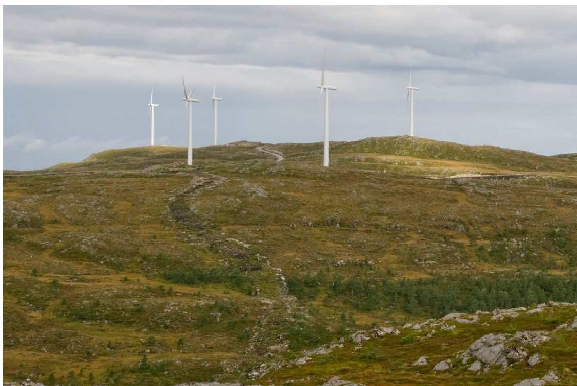
Figur 34: Kabelgrøften som ble etablert ved byggingen av Hitra 1 er et markant inngrep i landskapet. Foto: Einar Berg
