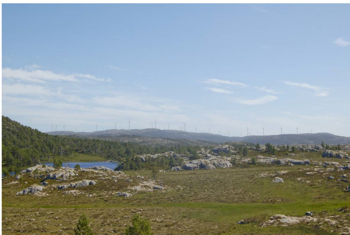
Figur 20: Hitra vindpark med utvidelse til Hitra 2 sett fra Havmyran. Avstand til nærmeste turbin er snaut 5 km. Foto: Einar Berg. Visualisering: Katrine Lone Bjørnstad
