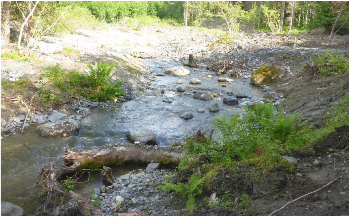
Figur 12: Fra midtre del av Hofstadelva etter sikringsarbeidet er gjennomført
