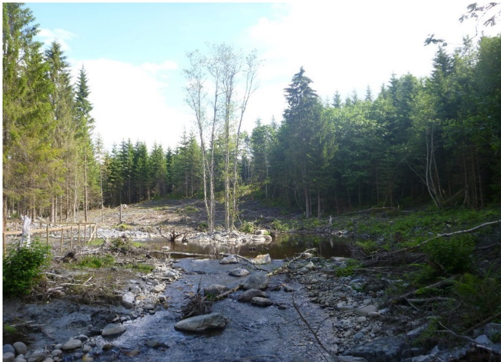
Figur 11: Hofstadelva etter endt sikringsarbeid
