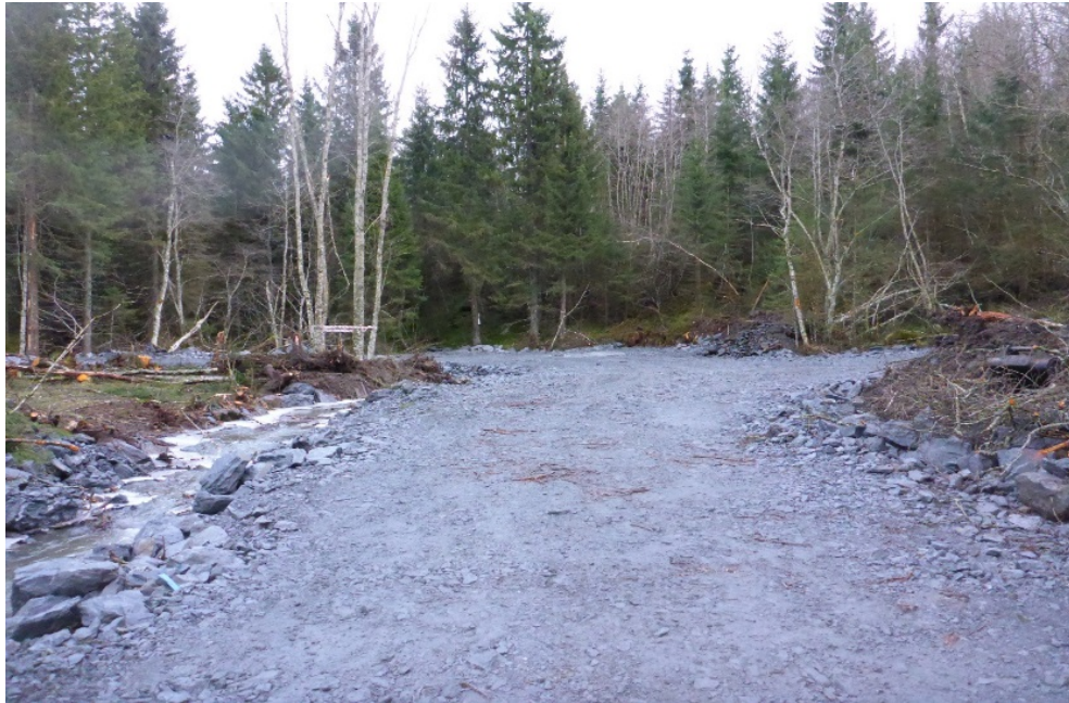
Figur 10: Hofstadelva etter utkjøring av steinmasser. Midlertidig løp ved siden av anleggsveien
