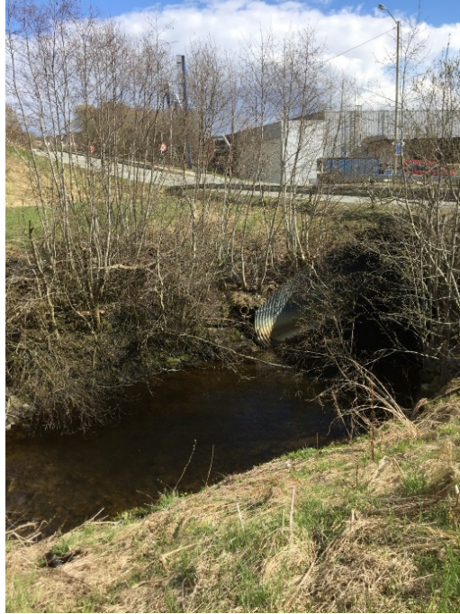
Figur 6: Erosjonssikringen avsluttes i nedstrøms ende mot kulverten ved Tegilverksveien.
