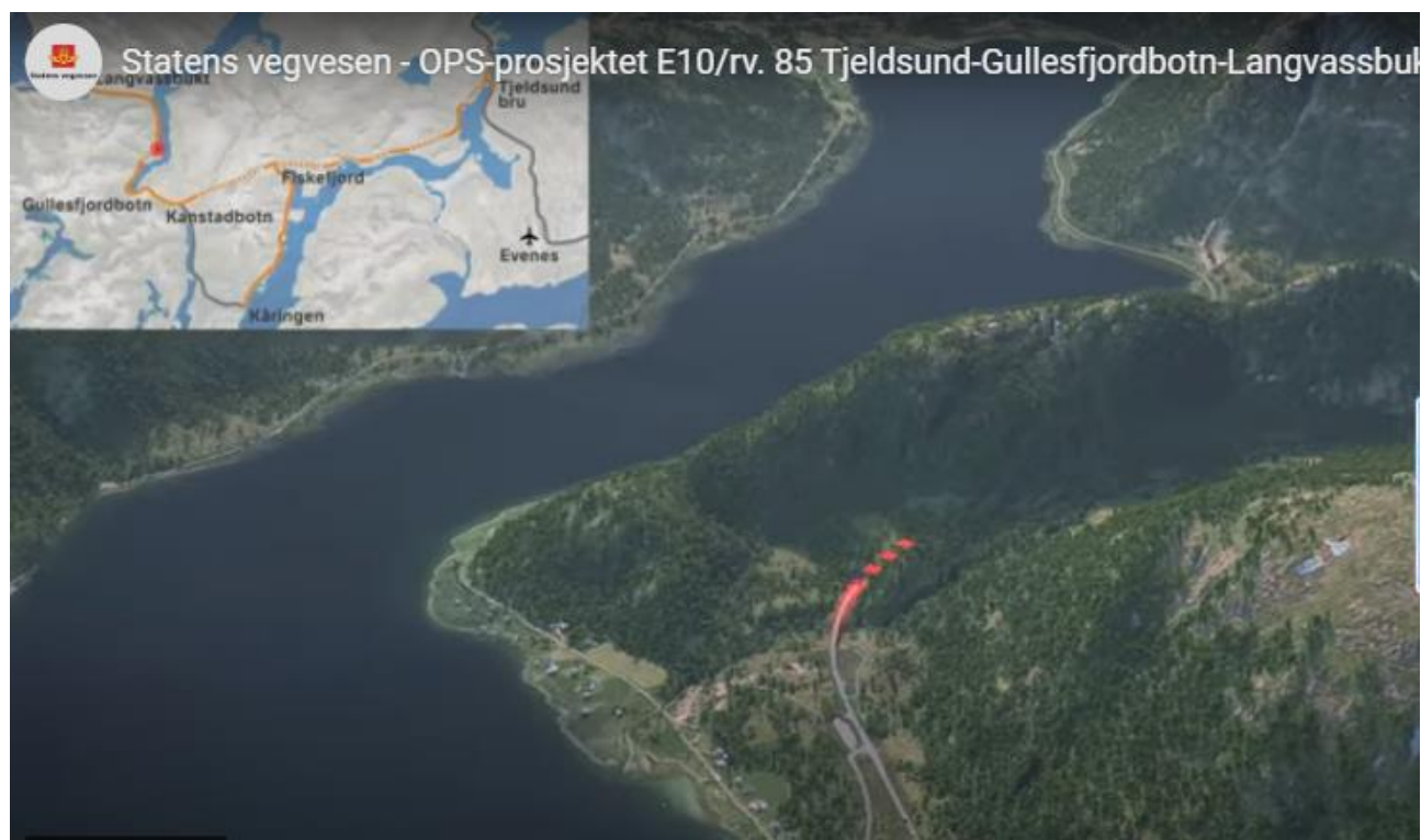
Figur 2-9 OPS-prosjektet E10/rv. 85 Tjeldsund–Gullesfjordbotn–Langvassbukt. Ny Brattfjell tunnel og ny bro over Våtvollelva.
