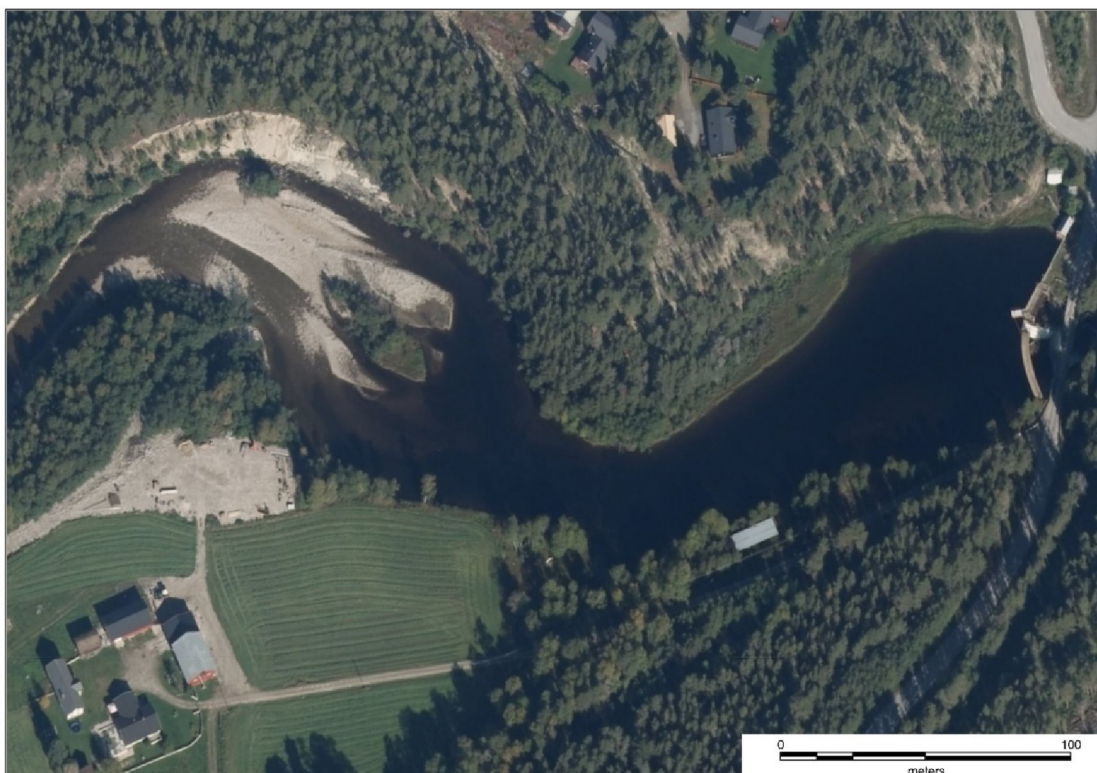
Figur 21. Inntaksbasseng gamle Sølna kraftverk, med vannstand ca. på HRV.
