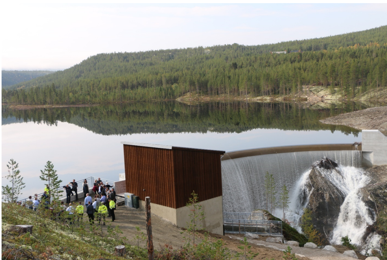
Figur 25. Inntaksdam ved Malmtektea for nye Sølva kraftverk. Dammen holder oppe et betydelig vannspeil i området, hvor det tidligere var et elveløp.
