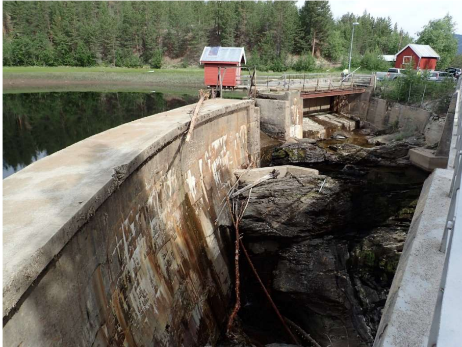
Figur 2 Sølva gamle dam, luftsiden
