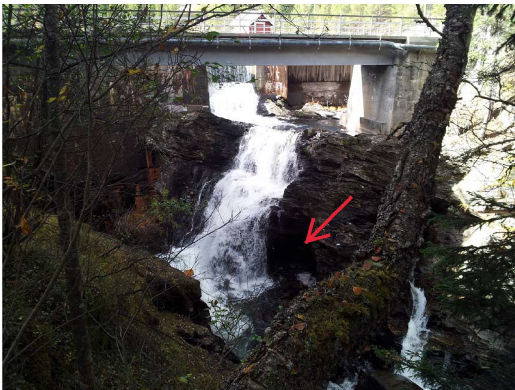
Figur 20. Fylkesvegbrua med Sølndammen i bakgrunnen. Utløpet fra tappetunnelen er markert med rød pil.
