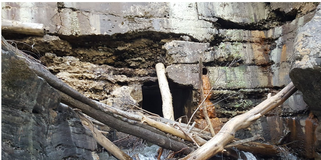
Figur 17. Foten av Sølndammen har betydelige sprekkdannelser og deler av damfoten i området ved utløpet av tappeløpet fra bunnluken er sterkt forvitret.
