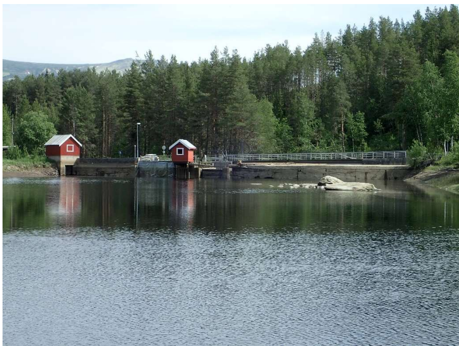
Figur 3 Sølva gamle dam, vannsiden
