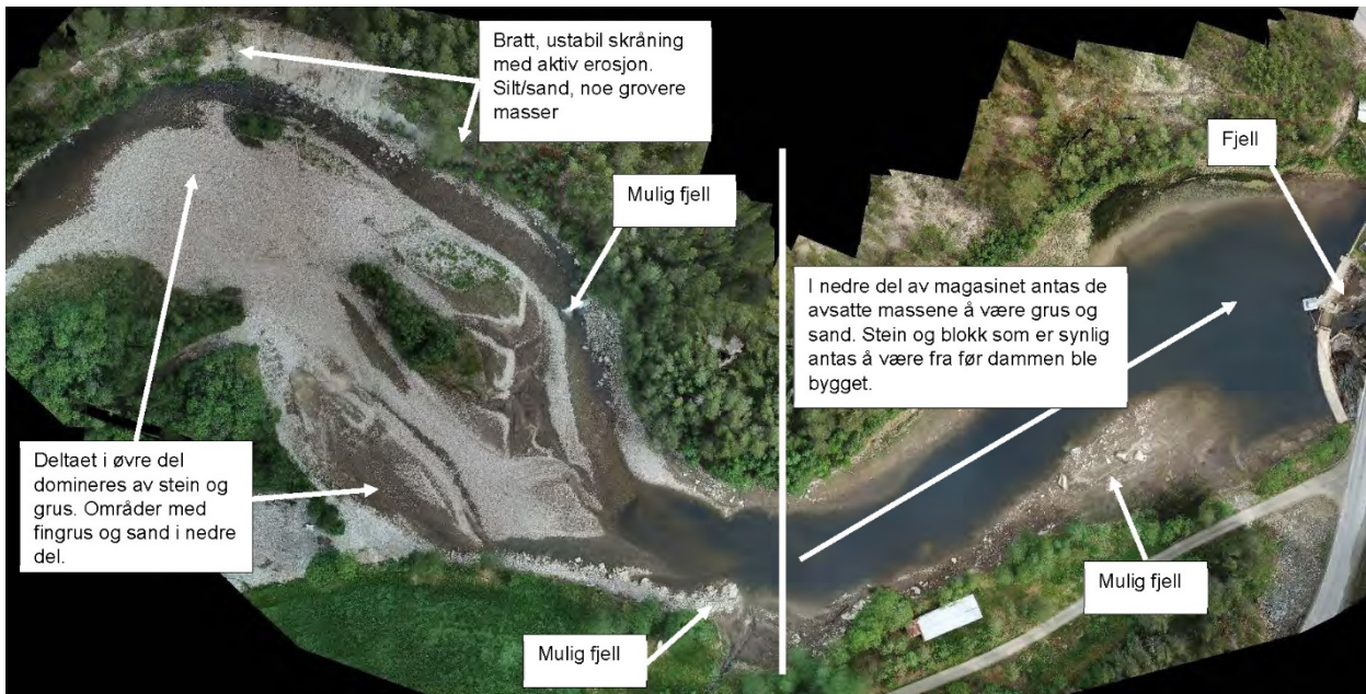
Figur 35. Dronefoto av inntaksbassenget med beskrivelse av avsatte masser og lokalisering av skråning med aktiv erosjon.
