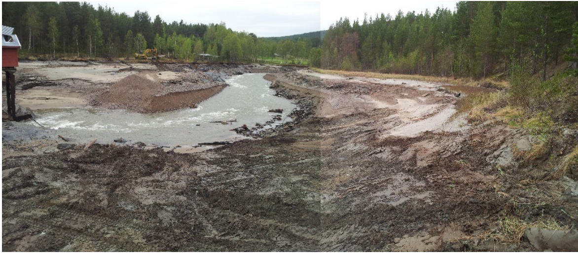
Figur 31. Bilde med nedre del av inntaksbassenget delvis nedtappet, lukehus for tappetunnelen kan sees i venstre bildekant. Bildet viser at i denne delen av inntaksbassenget er det avsatt finmateriale som vil gi godt grunnlag for reetablering av vegetasjon på store deler av arealet som vil bli permanent tørrlagt ved fjerning av dammen.
