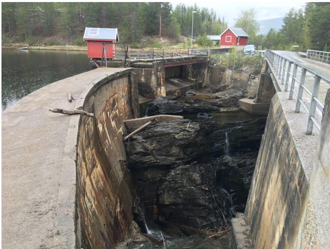
Figur 13. Sølnadammen sett mot nordre landfeste. Fylkesvegbrua til høyre i bildet.
