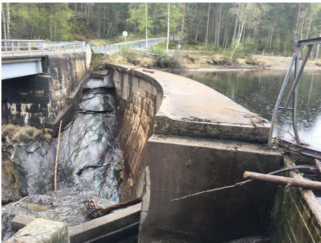
Figur 14. Sølnadammens overløpsseksjon, sett mot søndre landfeste med fylkesvegen i bakgrunnen.
