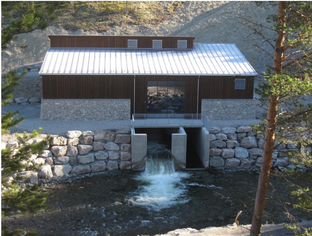
Figur 26. Kraftstasjonsbygningen til nye Sølva kraftverk.
