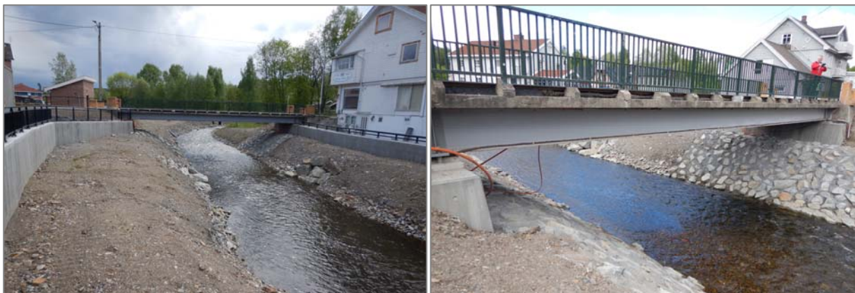
Figur 3.4 Augedalsbrua over Vigga, sett fra nedstrøms (venstre) og oppstrøms (høyre). Foto: H. Øverland
