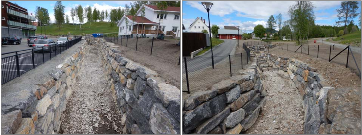
Figur 3.15 Åpning (venstre) og sikring av Gullåa (høyre), sett fra nedstrøms. Foto: H. Øverland
