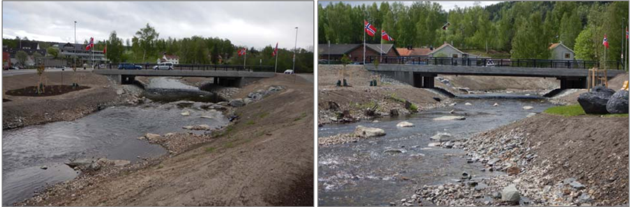
Figur 3.6 Orhagavegen bru over Vigga, sett fra nedstrøms (venstre) og oppstrøms (høyre). Foto: H. Øverland
