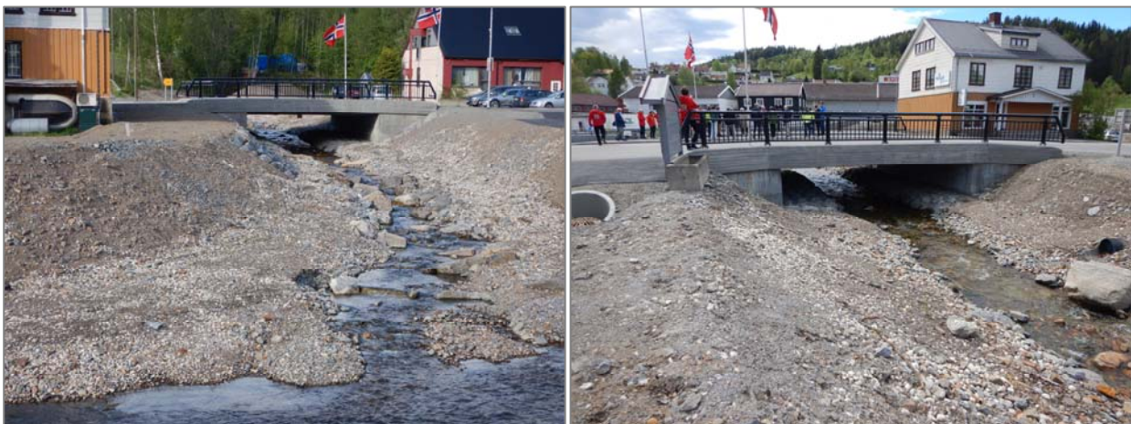
Figur 3.7 Storlinna bru over Eggeelva, sett fra nedstrøms (venstre) og oppstrøms (høyre). Foto: H. Øverland
