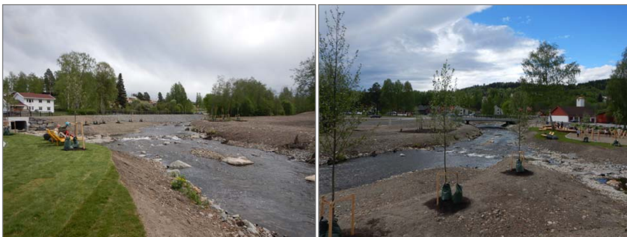
Figur 3.13 Samløpet av Gullåa med Vigga, sett fra nedstrøms (venstre) og oppstrøms (høyre). Tilbaketrunket flomvoll langs Viggas venstre bredd frem til Orhagavegen. Foto: H. Øverland
