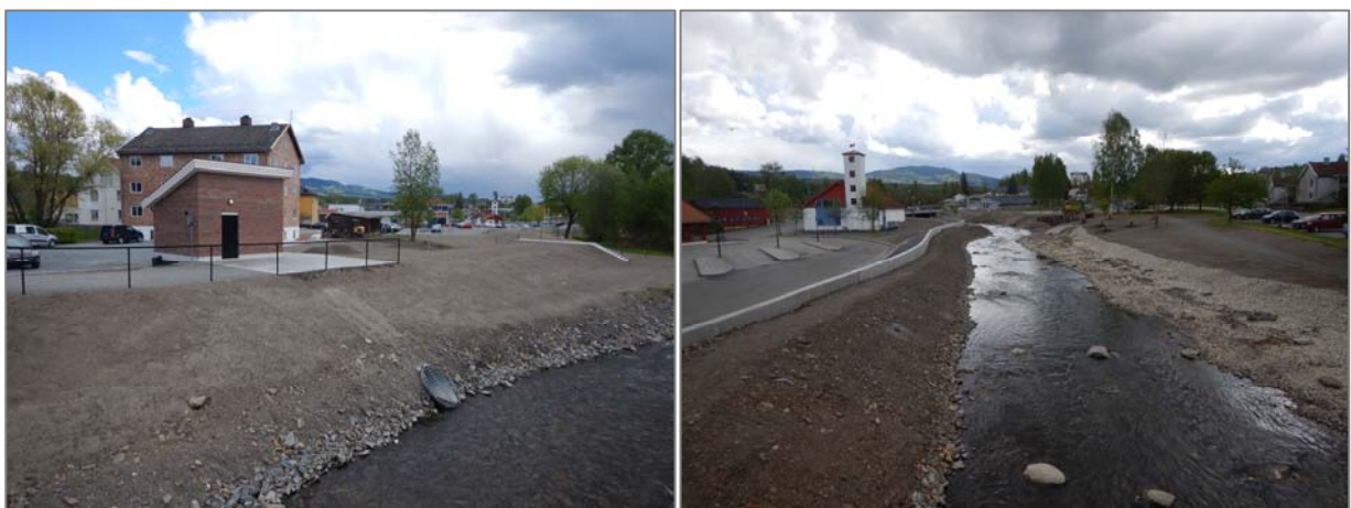
Figur 3.12 Flomvoll på Viggas høyre bredd oppstrøms Augedalsbrua (venstre) og flommur langs høyre bredd oppstrøms Torgbrua. Foto: H. Øverland
