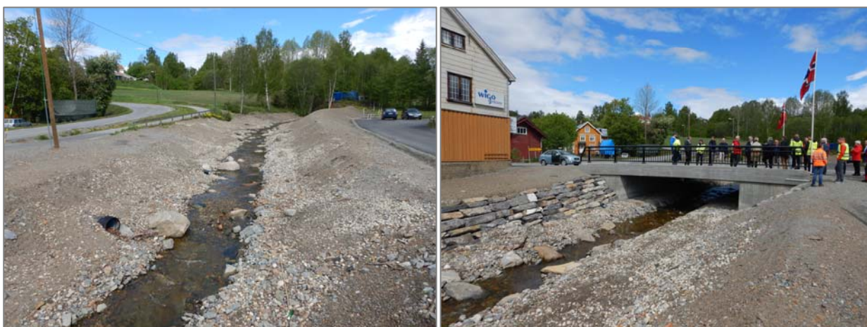
Figur 3.14 Flomvoll og terrengheving /-oppfylling langs Eggeelva, sett fra nedstrøms (venstre) og tørrmur nedstrøms Storlinna bru over Eggeelva (høyre). Foto: H. Øverland
