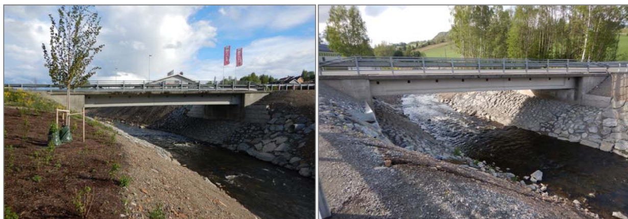
Figur 3.3 Storlinna bru over Vigga sett fra nedstrøms (venstre) og oppstrøms (høyre). Foto: H. Øverland
