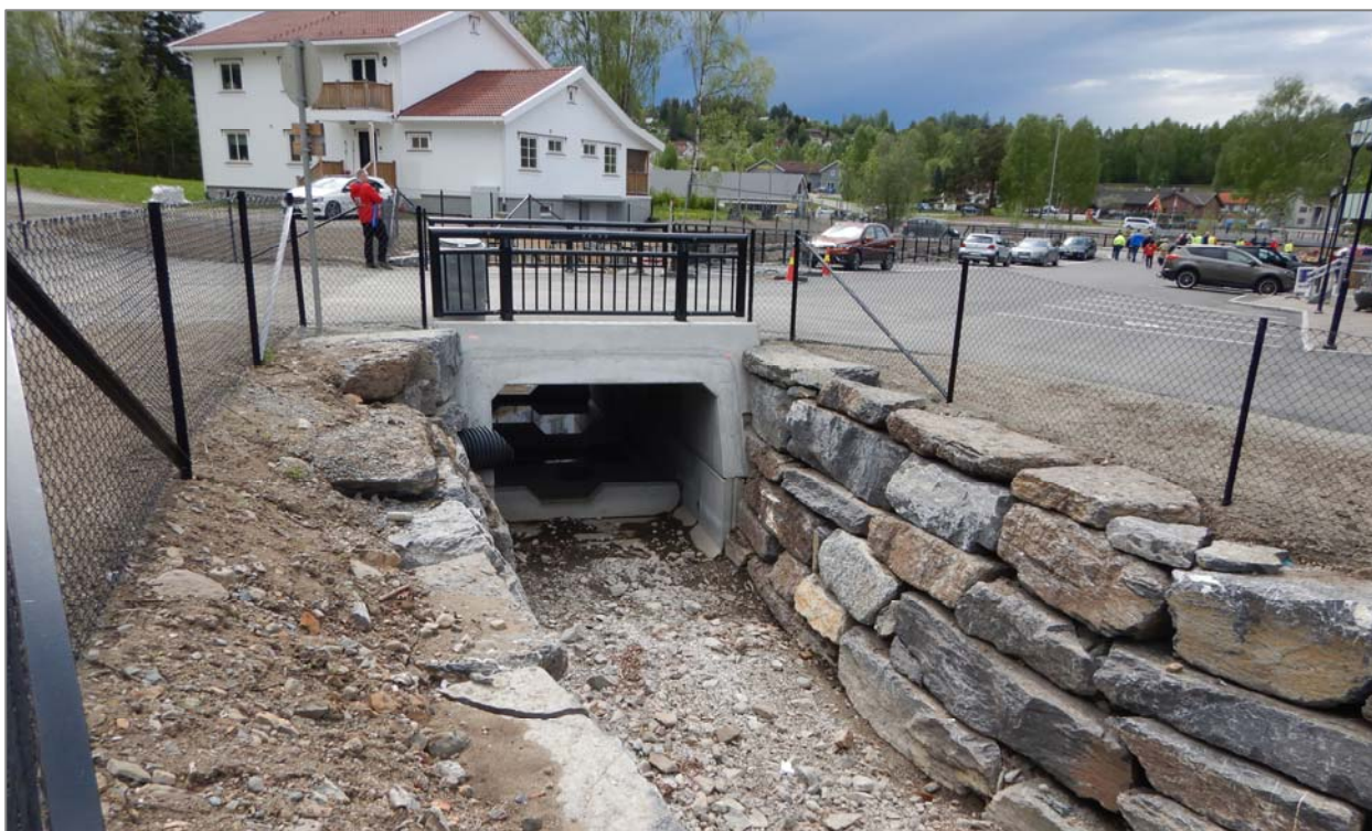
Figur 3.9 Parkvegen bru over Gullåa, sett fra oppstrøms. Foto: H. Øverland
