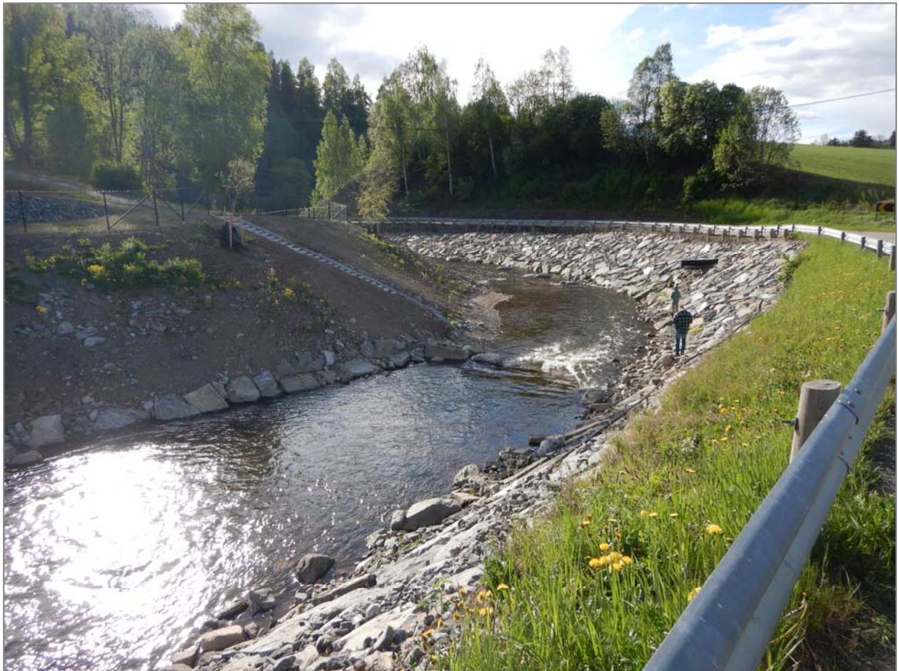
Figur 3.10 Erosjonssikring i Viggas yttersving nedstrøms Brandbu sentrum. Foto: H. Øverland
