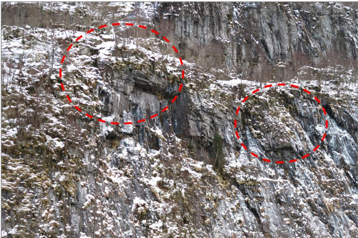
Bilde 4. Eksempler av observerte potensielle løснеområder for steinsprang i høyreliggende skråning, se stiplete sirkler. Bildet er tatt mot sør.
