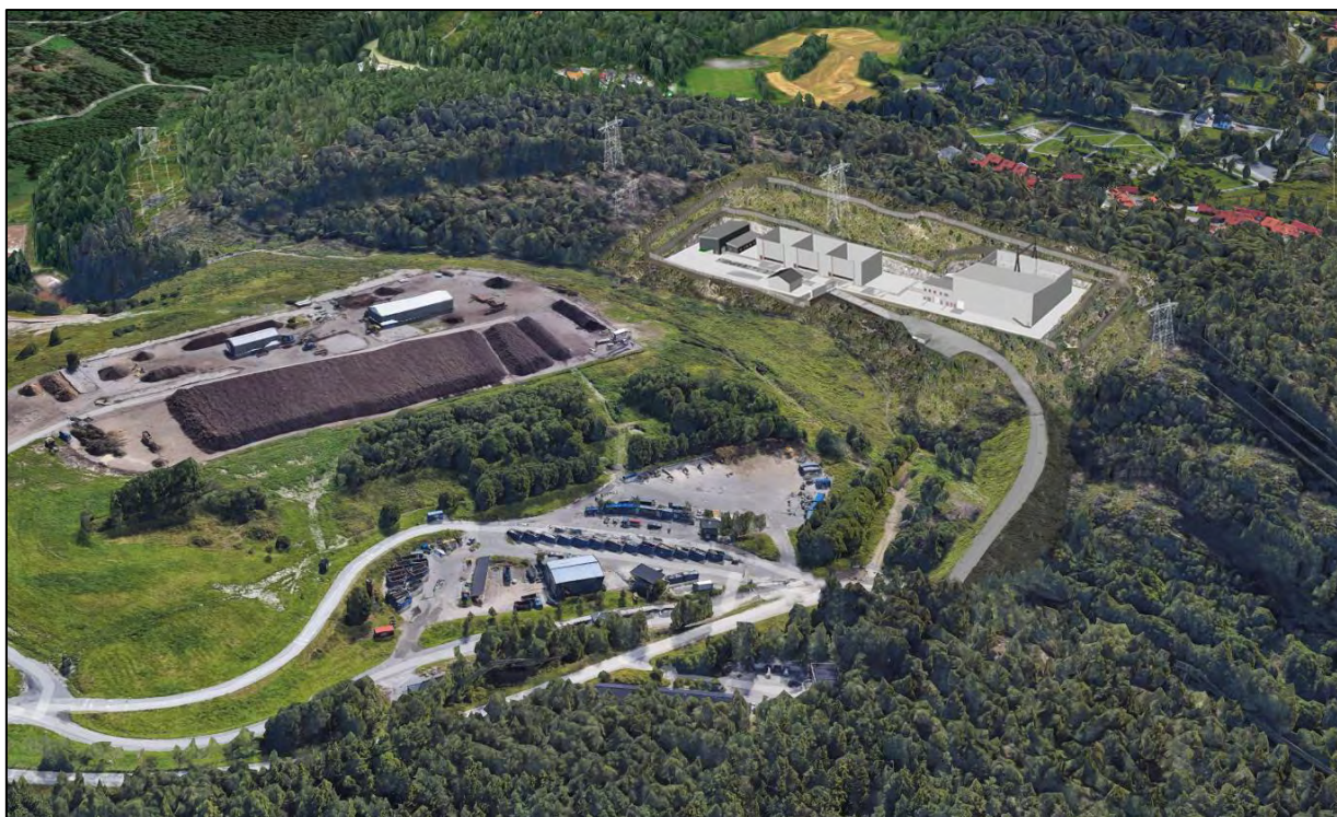
Figur 4-12: Visualisering av ny transformatorstasjon ved Liåsen og Grønmo gjenvinningsstasjon. Visualisering: E. Hjerkin, Multiconsult.
