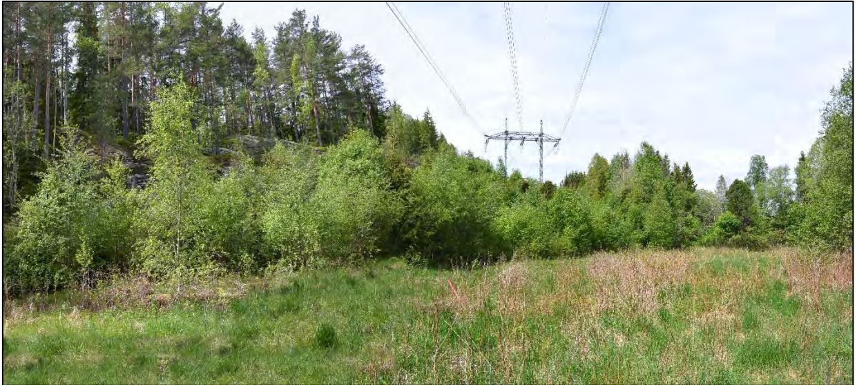
Figur 4-16. Område for ny transformatorstasjon. Det nye anlegget sprenges inn i bergformasjonen til venstre i bildet. Foto: E. Hjerkin, Multiconsult.
