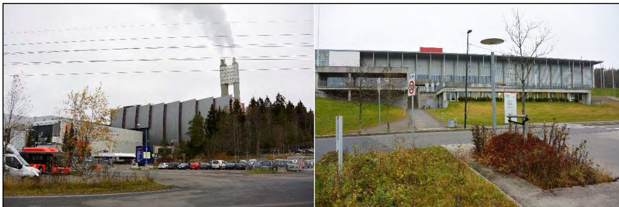
Figur 4-10. Området er preget av nærings- og industribyggelse. Bildet til venstre viser energigjennvinningsanlegg på Klemetsrud. Bildet til høyre viser Bjørnholt Videregående Skole. Foto: E. Hjerkin, Multiconsult.
