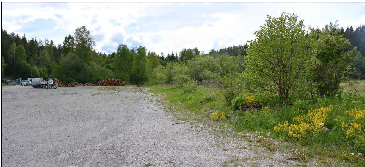
Figur 4-19. Utsikt fra utfartsparkeringen sør i delområdet. Det nye anlegget sprenges inn i bergformasjonen som ligger i bakkant til høyre i bildet. Det vil være en del skogsvegetasjon i området som vil begrense innsynet til transformatorstasjonen. Foto: E. Hjerkin, Multiconsult.
