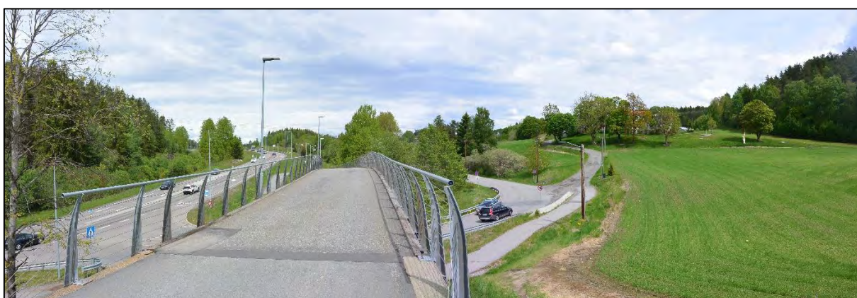
Figur 4-9. Området er preget av både veianlegg og kulturlandskap med vanlige gode visuelle egenskaper. Bildet viser Enebakkveien og Sørlikeveien og gården Sørli til høyre i bildet. Foto: E. Hjerkin, Multiconsult.
