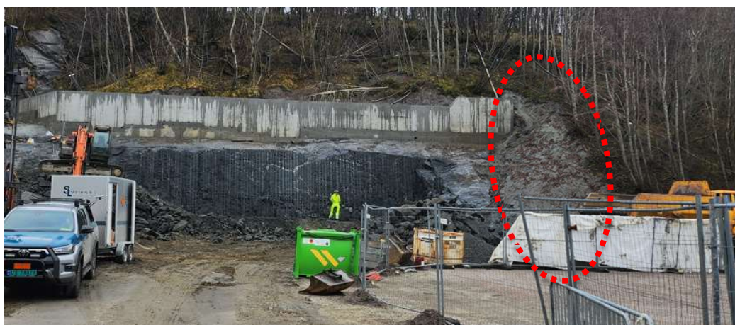
Figur 2: Bilde fra tomte, med avmerket løsmasseskjæring som omtales i notatet.
