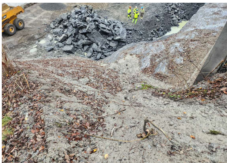
Figur 4: Bilde tatt nedover, ved avslutning av betongmur.
