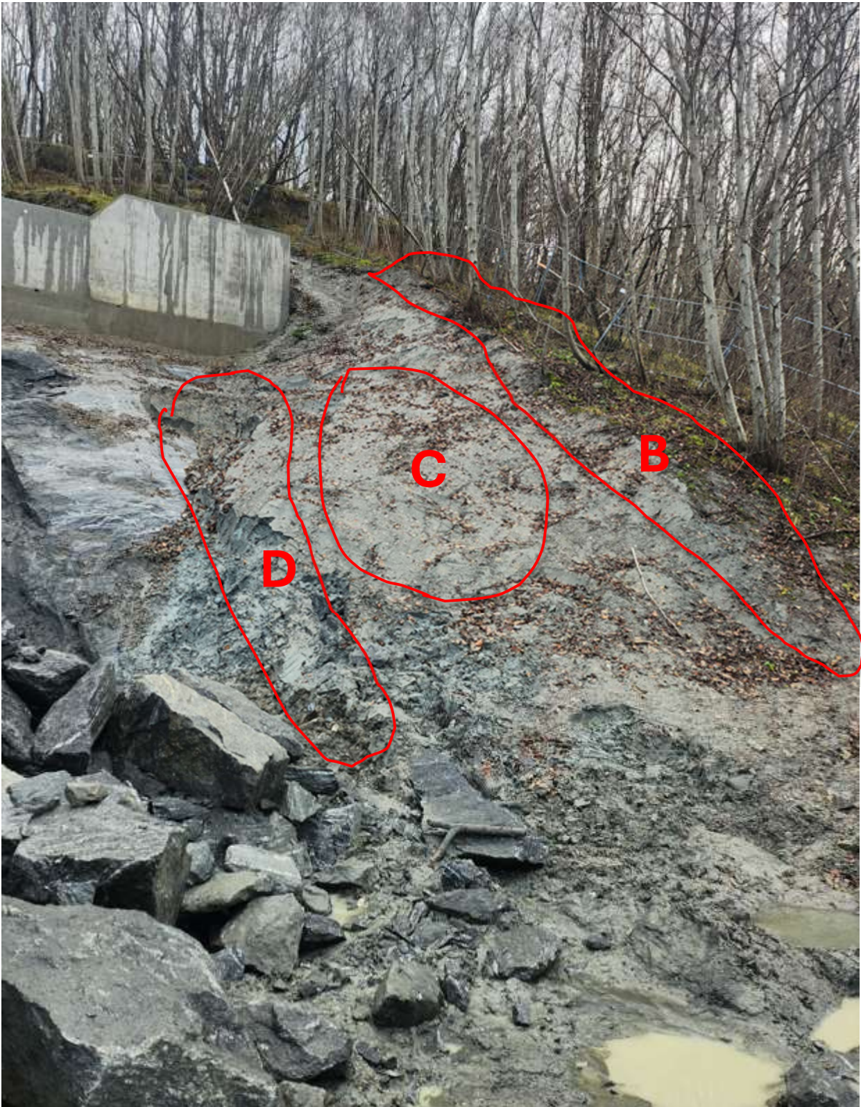
Figur 7: Bilde med avmerket ulike tiltak ihht listen over.
