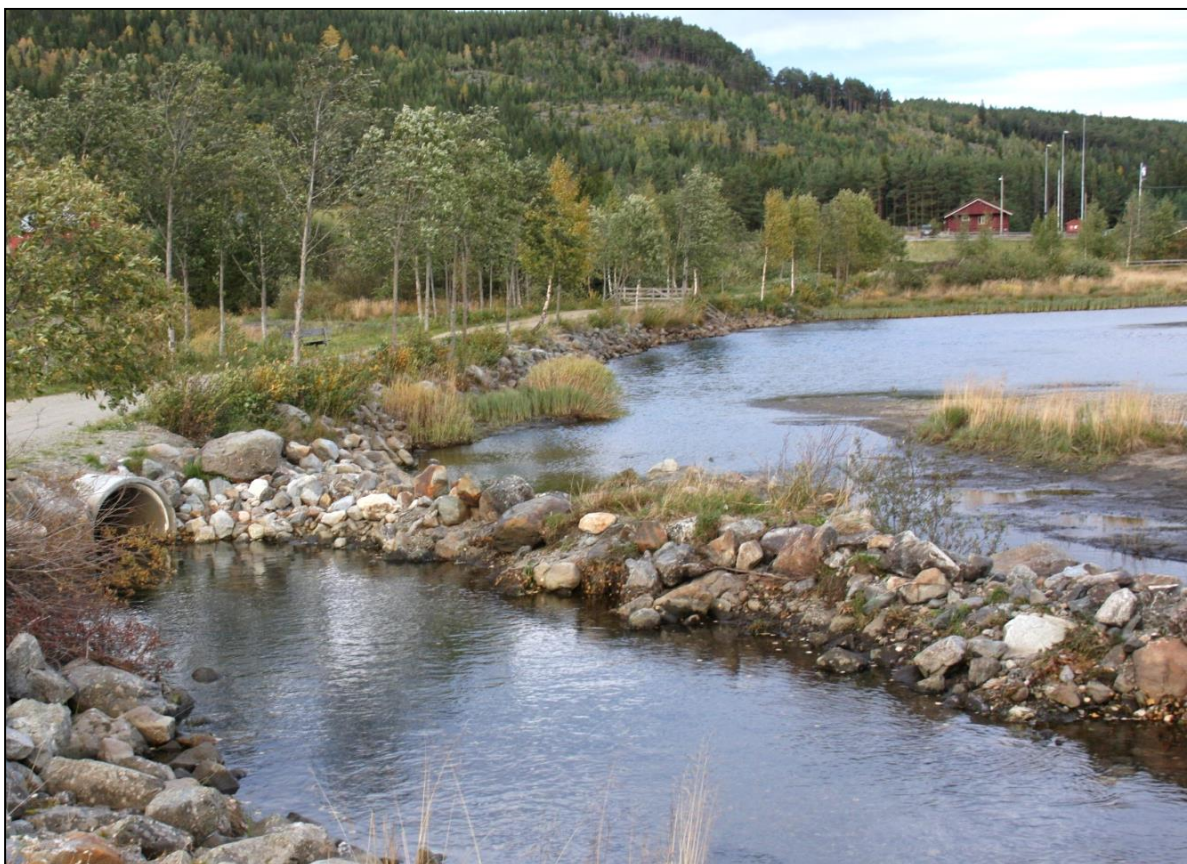
Storåne (kote 429-427) 17. september 2009: 6 m 3 /s
