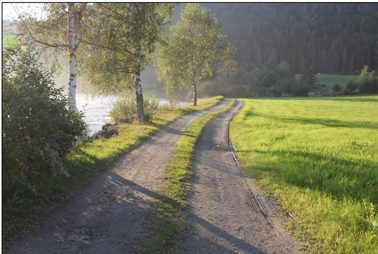
Figur 5: Forlenget åpen utløpskanal skal graves ut omtrent i overgangen mellom gårdsvei og dyrket mark. Ny vei-trasé flyttes til innsiden av kanalen. Foto 5. september 2024.
