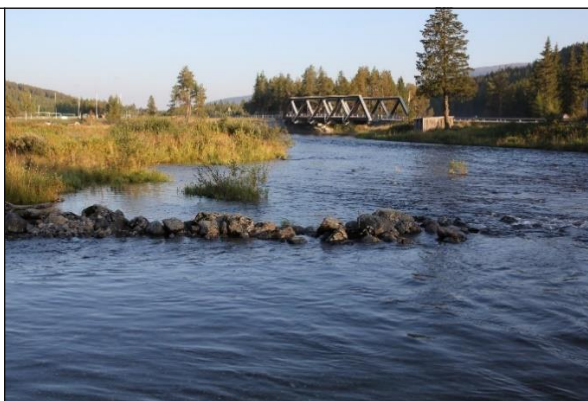
En enkel steinfylling (t.h.) leder vannet fram til kulvert (t.v.) som forsyner Tveitahølen med ellevann.
