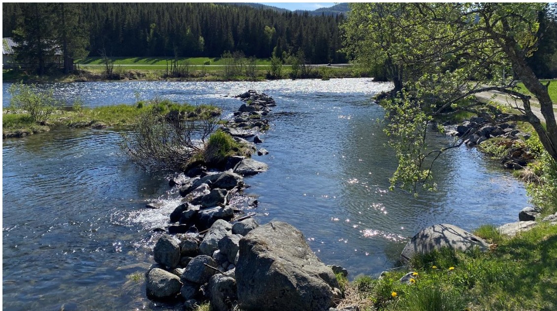
Figur 2-1. Dagens inntak ved Tveitahølen. Bilde er tatt 22.05.2024 med vannføring på ca. 19 m 3 /s.
