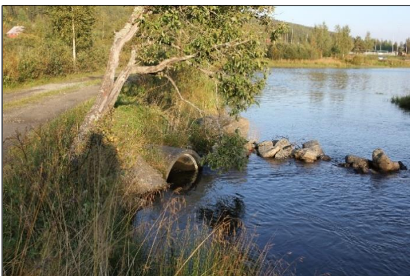
En enkel steinfylling (t.h.) leder vannet fram til kulvert (t.v.) som forsyner Tveitahølen med ellevann.
