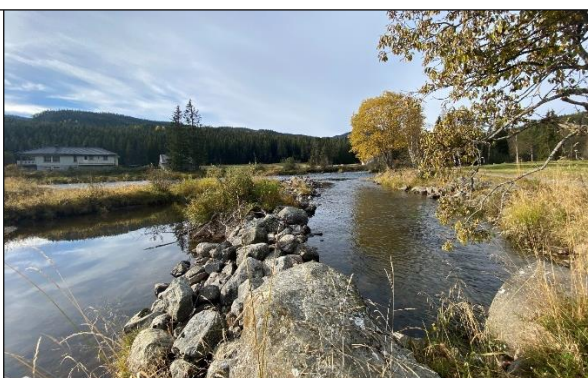
Steinfyllingen som leder vann fra Storåne (i bakgrunnen) inn mot kulvert til Tveitahølen.
