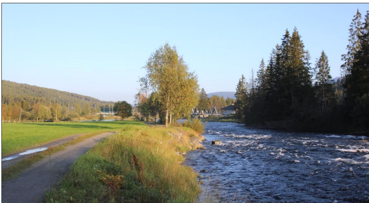
Utløpskanal graves ned i gårdsvei/dyrket mark til venstre.
