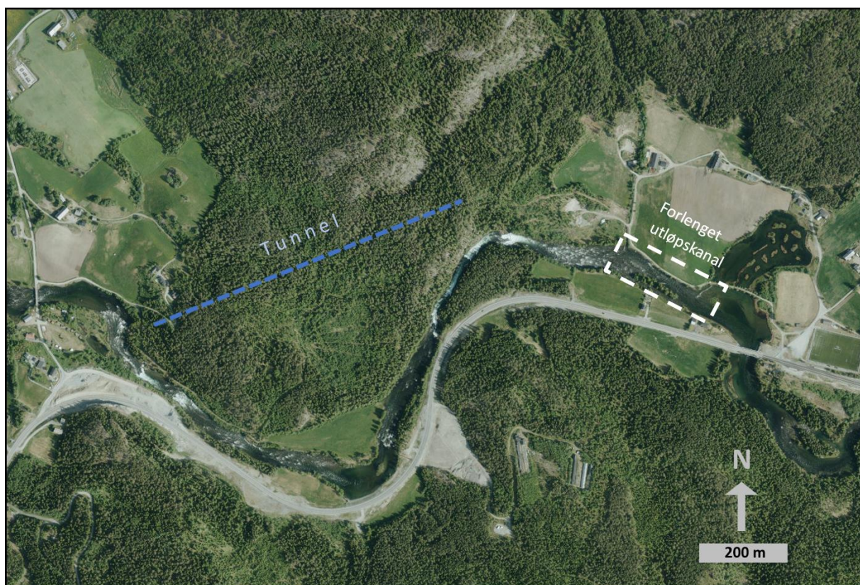
Figur 20: Flyfoto av Føssaberge 2023. Kilde: kart.1881.no. Blå stiptet linje viser strekning med vannvei i tunnel (konsesjonsgitt), mens tiltaksområdet for forlenget utløpskanal er grovt avgrenset med stiptet rektangel.
