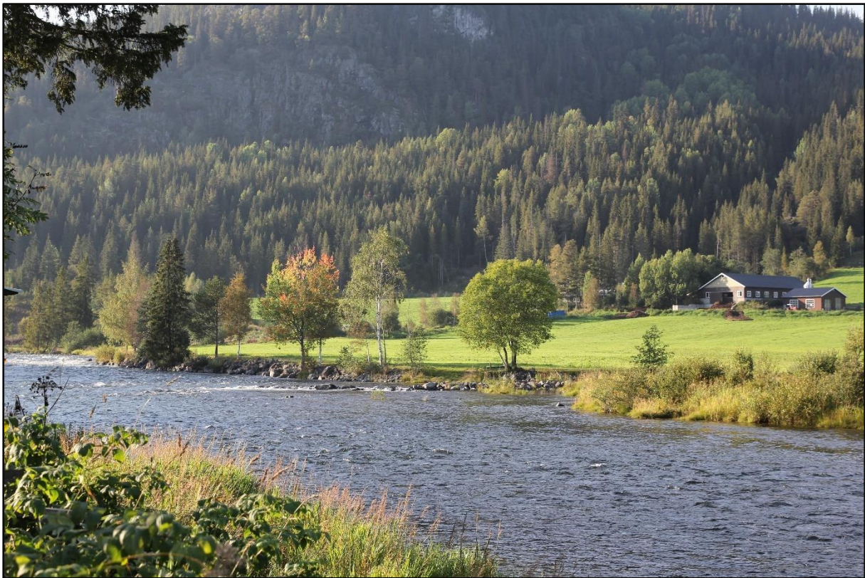
Figur 2. Storåne på strekningen hvor forlenget åpen utløpskanal skal parallellføres med elveløpet gjennom dyrket mark og tilliggende gårdsvei (lite synlig) nord for elva, og deretter avløses av et nedgravd/neddykket utslippsrør. Ca. 200 m elvestrekning i Storåne får redusert vannføring. Utslippspunkt blir sentralt i elveløpet til høyre i bildet. Foto 5. september 2024.
