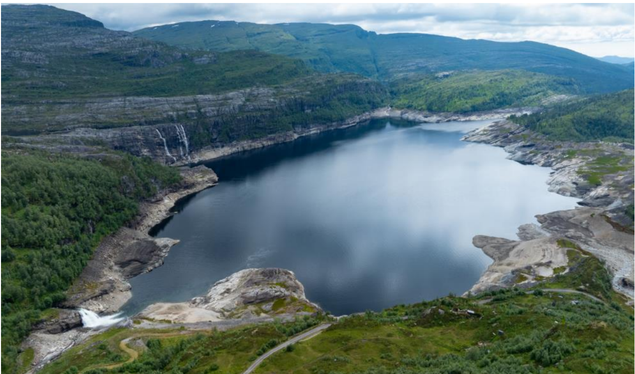
Figur 1-4. Bilde av reguleringsmagasinet Kvittingsvatnet tatt fra nord mot sydvest. Dagens kraftverksutløp er til venstre i bildet (Bilde Sweco).
