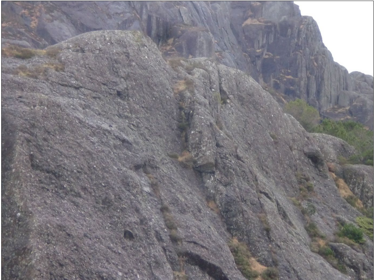
Figur 24: Bilete av blokk vurdert som ustabil ved infopunkt 5.
