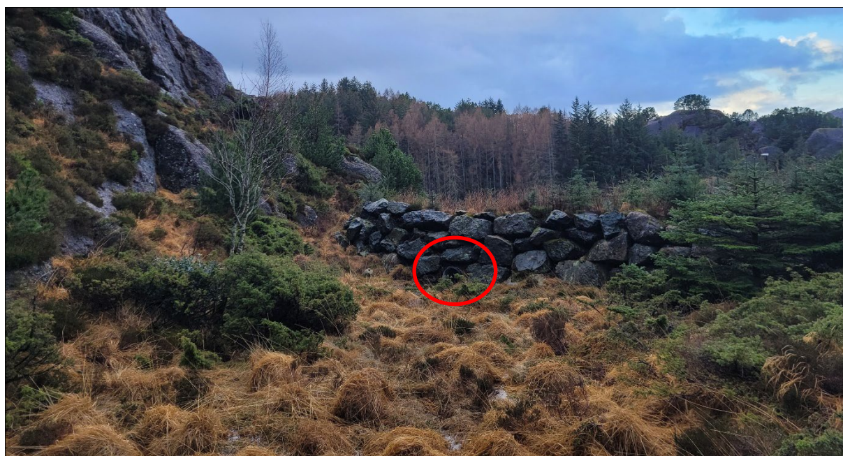
Figur 15: Biletet som viser nedre del av søkket, der dreneringa går vidare inn i kulvert og vidare i grøft og røyr mot sør. Biletet viser mot sørvest. Kulvert er markert med raud sirkel.
