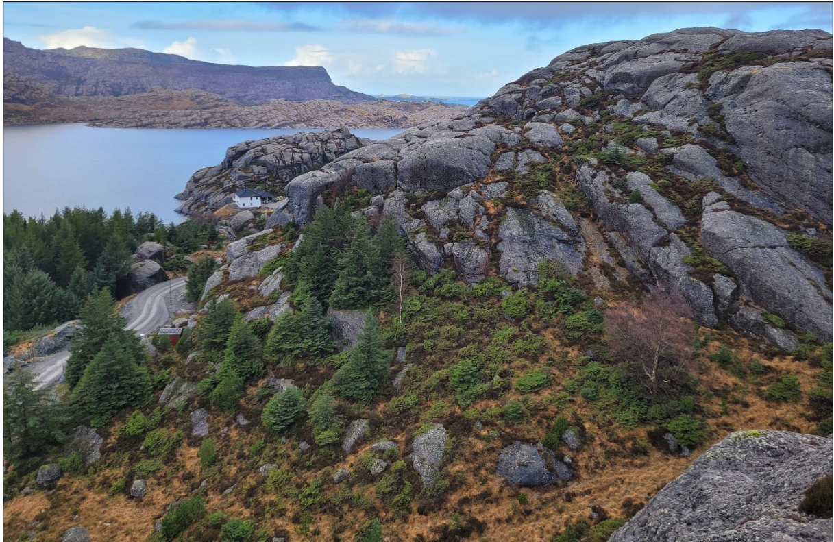
Figur 6: Påverknadsområdet ovanfor nordvestlege del av kartleggingsområdet består av relativt slak fjellside med enkelte små brattskrentar med høgde opp mot 3 m. Biletet er tatt mot nordvest.
