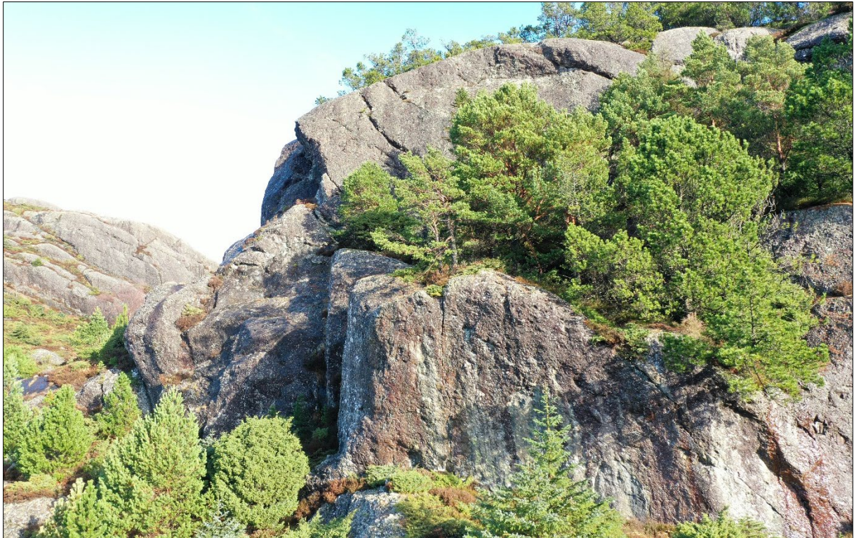
Figur 4: Påverknadsområdet ovanfor området der ny vegstrekning ligge, består av brattskrentar med høgde opp mot 6-7 m. Biletet er tatt mot nord.
