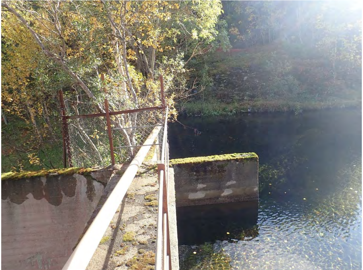
Figur 9. Damkrone sett fra ventilhusfundamenter.
