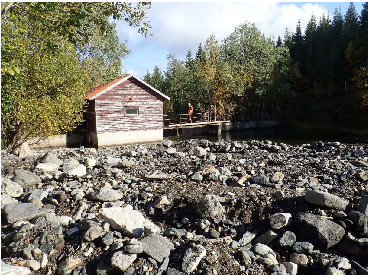
Figur 14. Masser i magasin sett fra oppstrøms.
