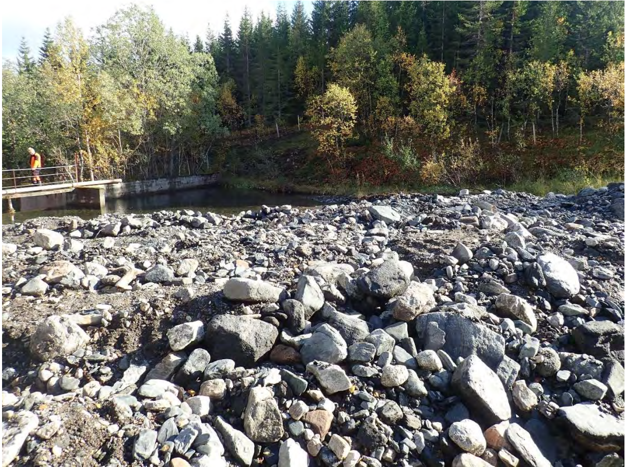
Figur 15. Masser i magasin sett oppstrøms.
