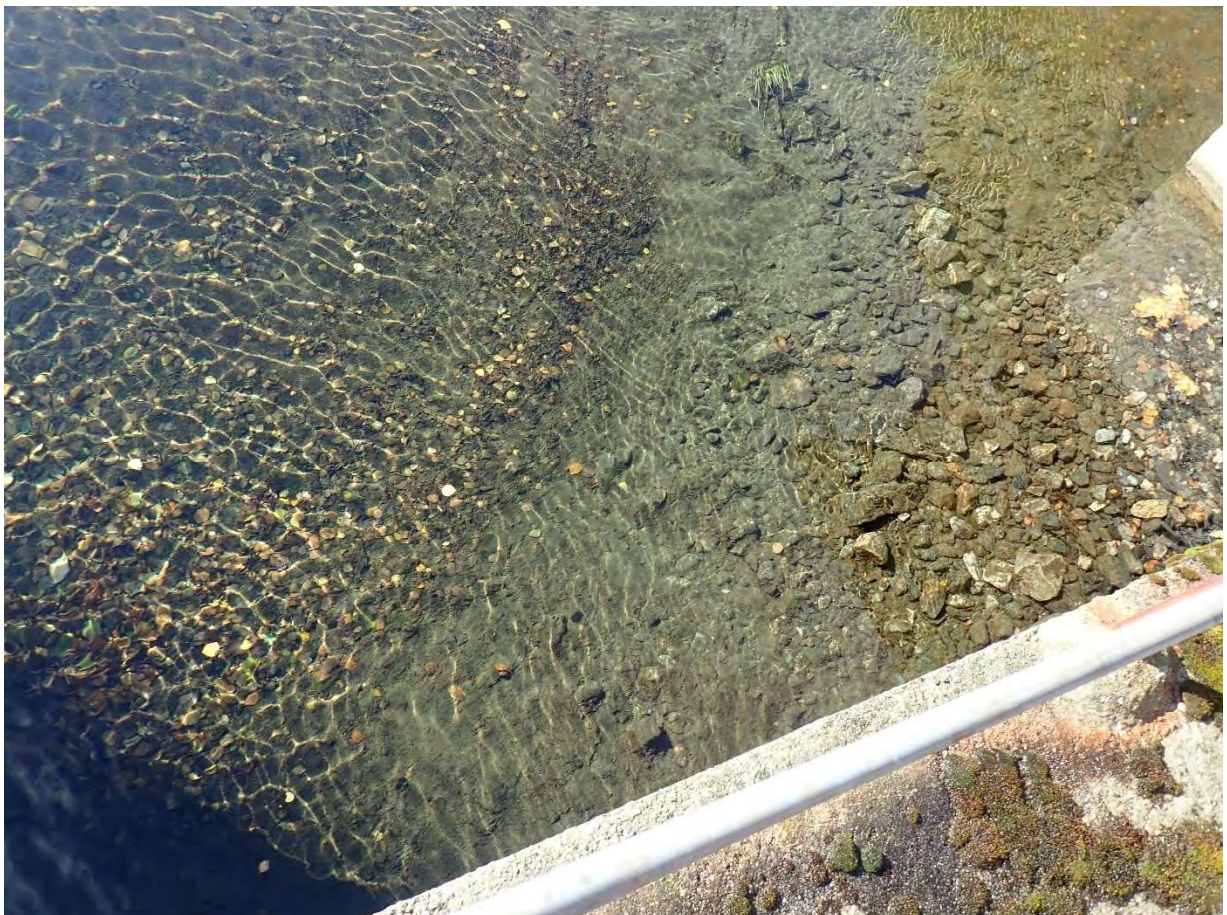
Figur 8. Masser i magasin ved dam/ventilhus.
