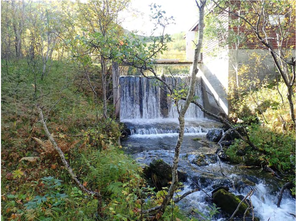
Figur 11. Nedstrøms overløp og ventilhus.
