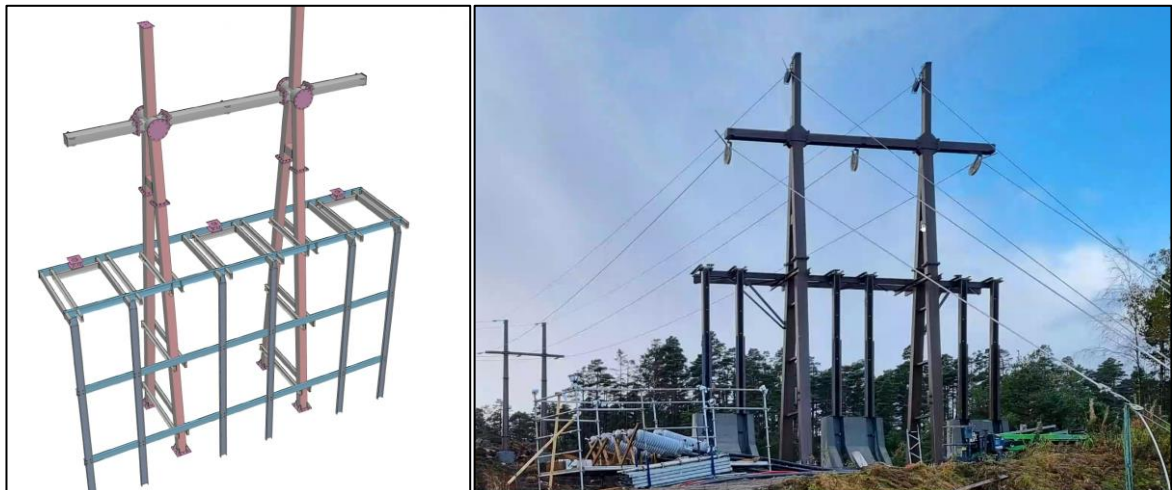
Figur 1-8. Illustrasjon og bilde av enkeltstående master som skal bygges øst og vest for Kristiansand transformatorstasjon (Kilde: Glitre Nett).
