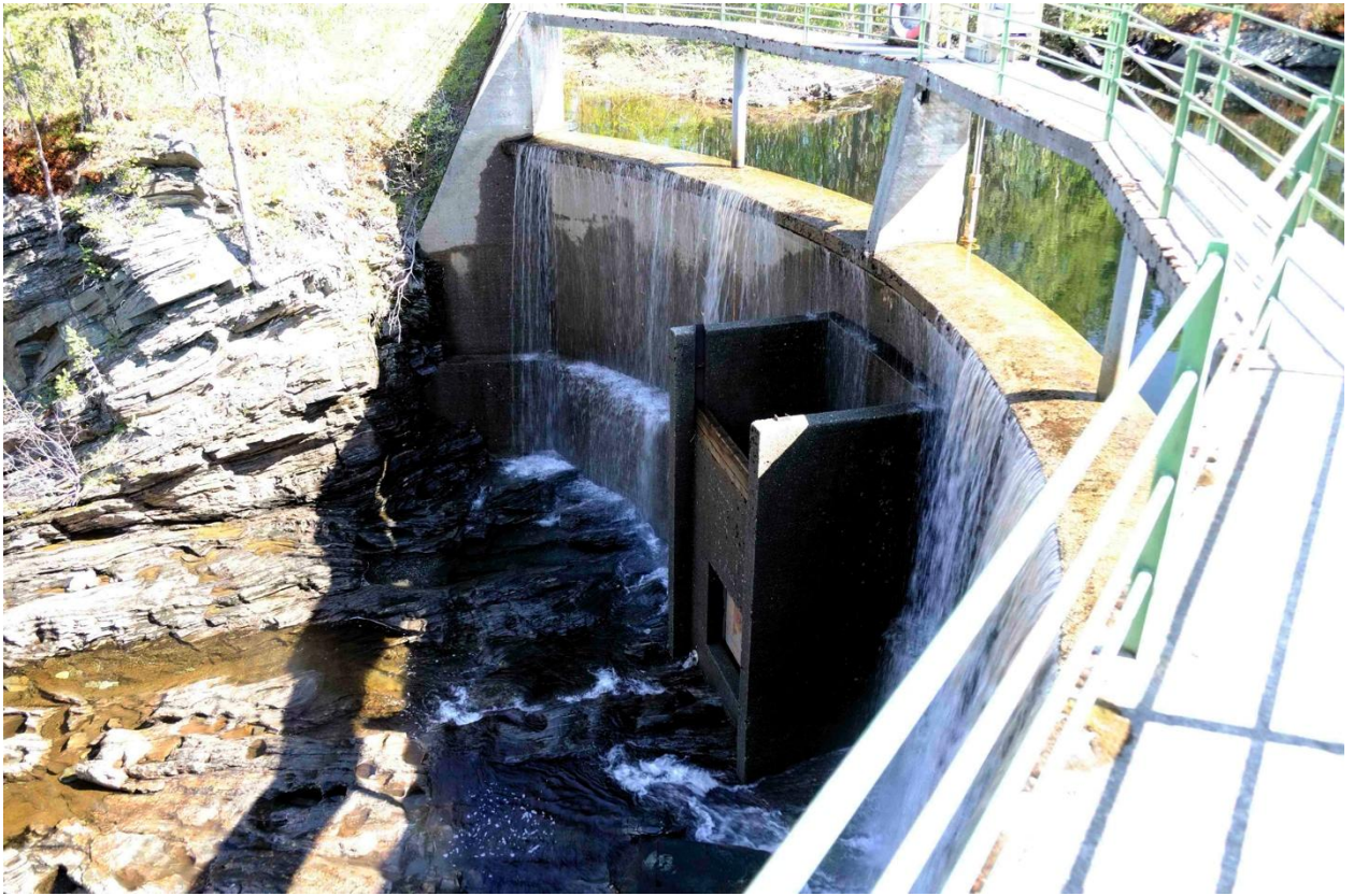
Figur 9 Lukkeordningen ved Rinna dam. Ubetydelig overløp den 30 mai 2014.
