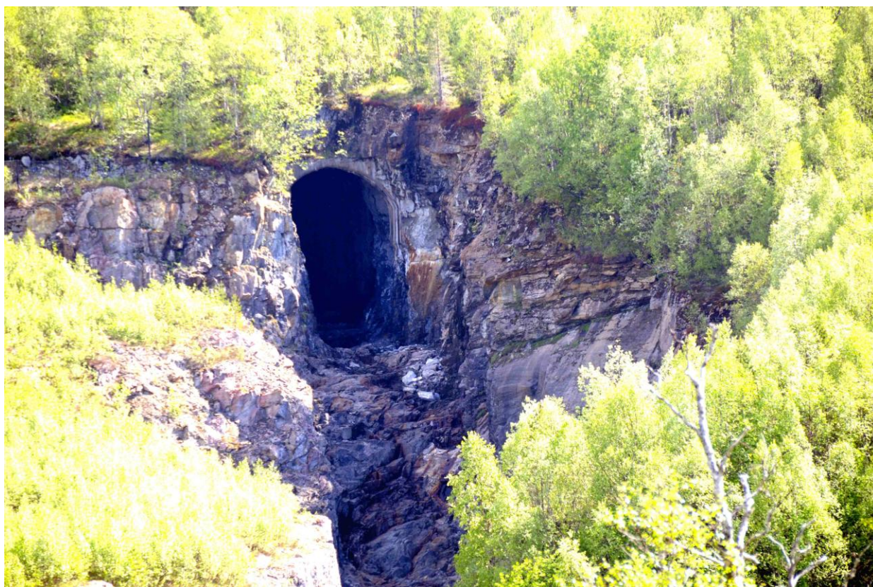
Figur 17 Tunnelåpningen fra en av tappetunnelene i Follsjøen.
