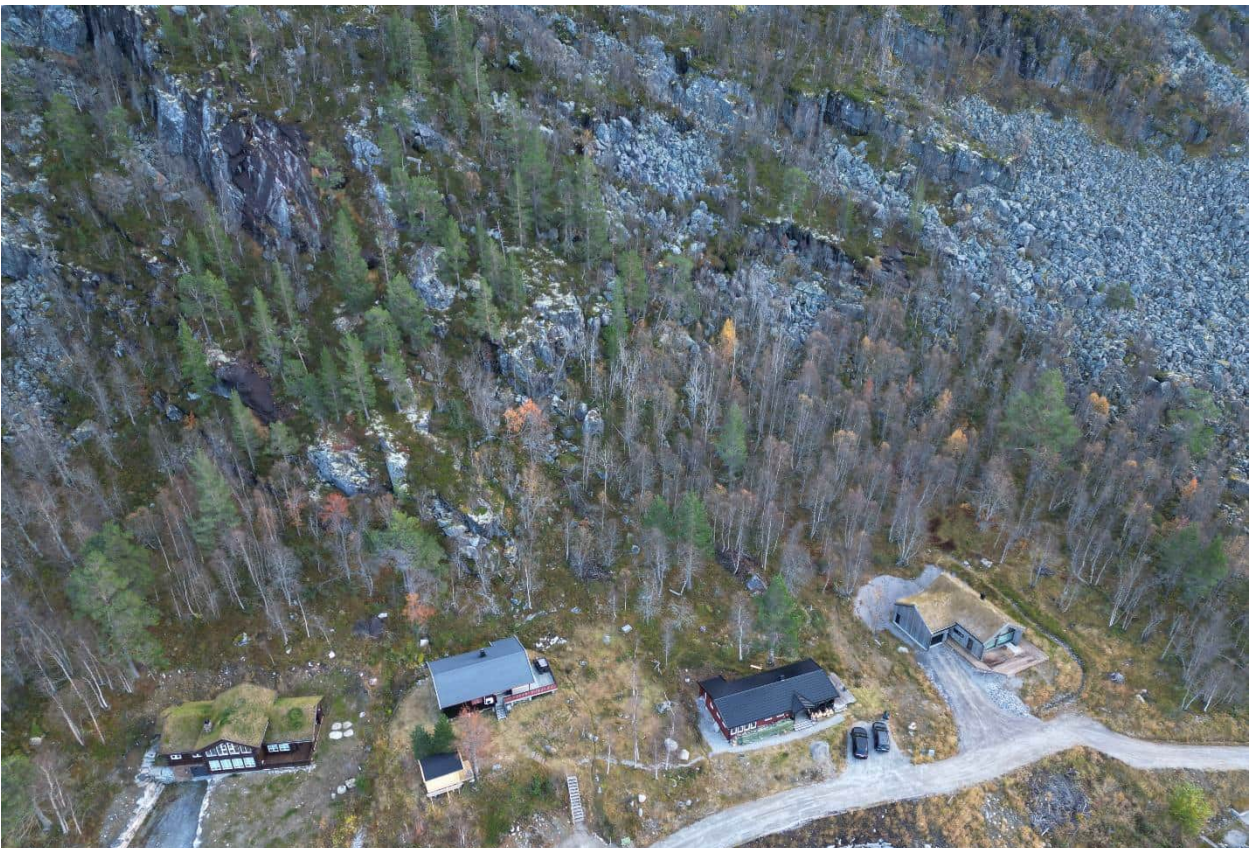
Bilde 13: Oversiktsbilde av hytter med adresse Hartevasstrondi 35, 37, 39 og 41 og overliggende terreng. Sett mot øst.
