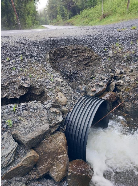
Figur 8: Stikkrenna under Slidrevegen oppstrøms.
