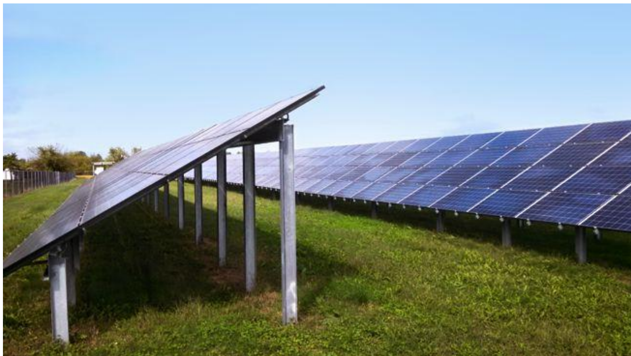
Figur 3-1: Fast-vinkel installasjonsløsning (foto: Willowbrook Solar).
