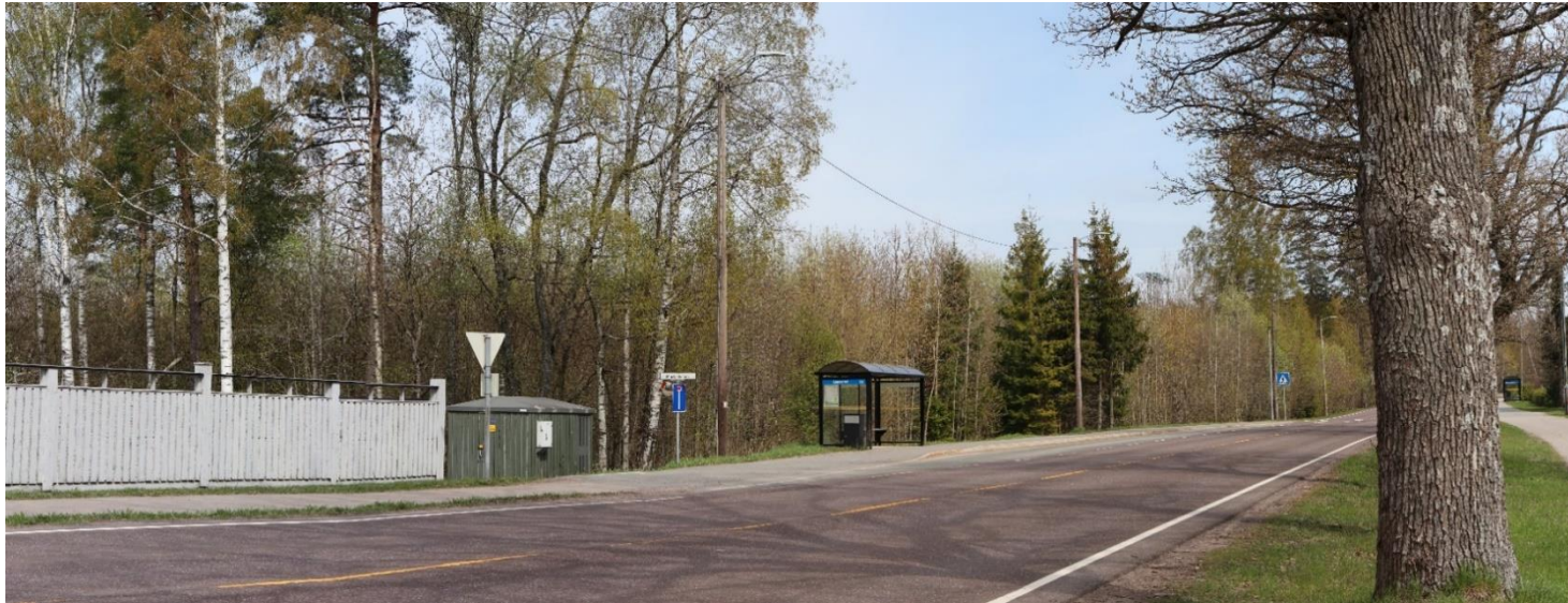
Figur 5-18: Førbilde av planområdet for solkraftverket, sett fra Hortensveien like ved krysset til Morkelvegen.
