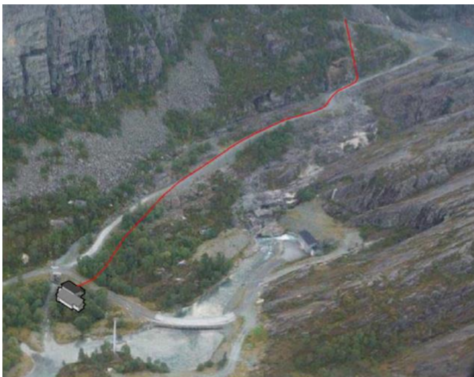
Figur 4. Bilete viser rørgate og planlagt plassering av ny kraftstasjon. Henta ifrå vedlegget til førespunaden.
