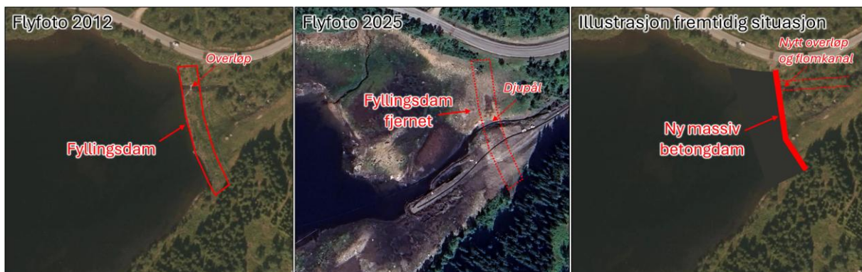
Figur 2-2. Flyfoto av utløpet til Storvatnet, hvor det tidligere var en fyllingsdam som ble fjernet i 2020 og planlegges å etablere en ny massivdam i betong.
