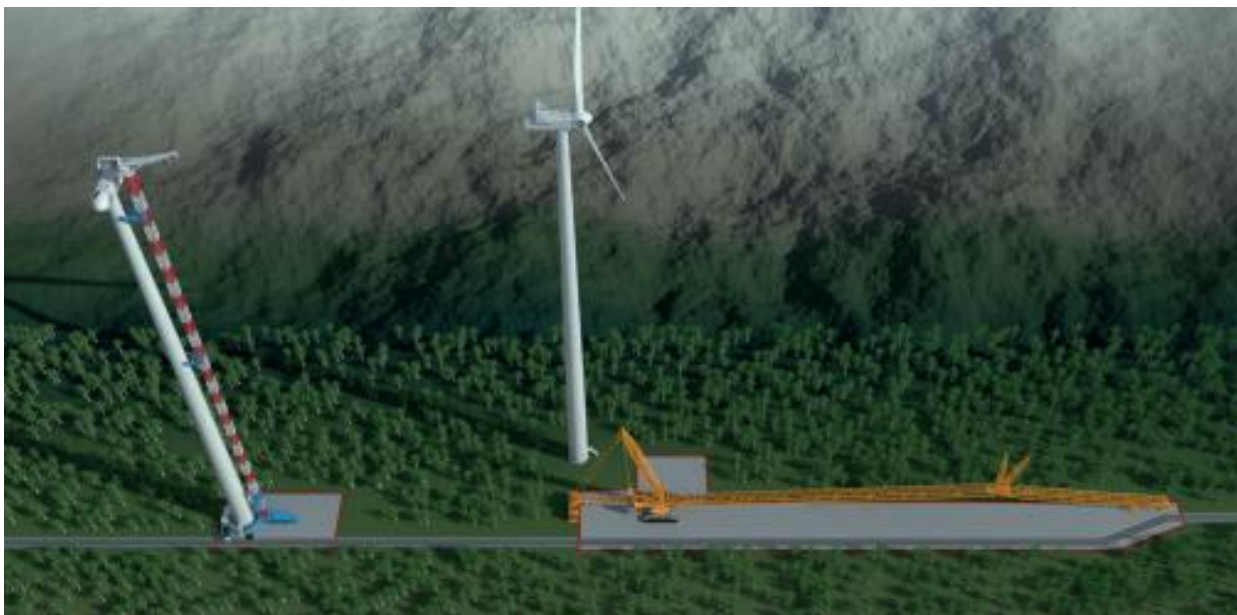
Figur 4-3 Illustrasjon av kranoppstillingsplass so gir redusert arealbehov
