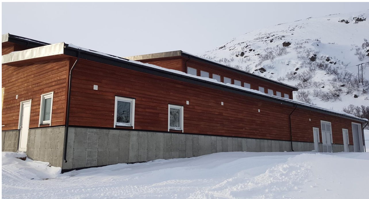
Figur 4-5 - eksisterende Kobbkroken transformatorstasjon ferdigstilt i 2018
