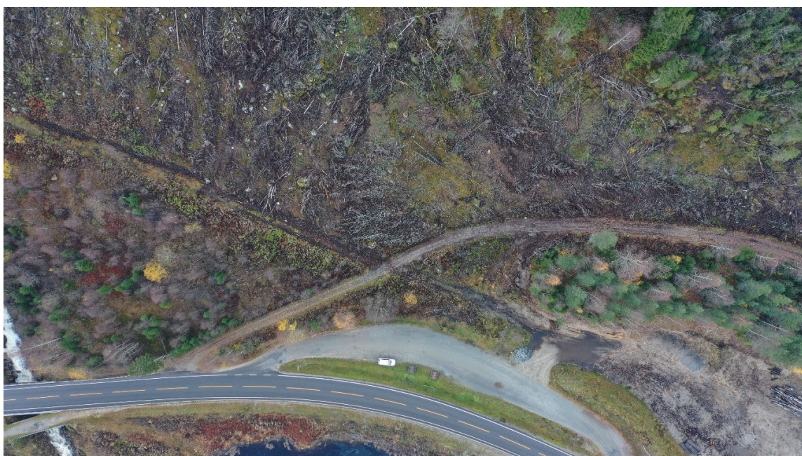
Figur 9. Steinur etter steinsprang over rasteplass ved riksvei 9. Bildet er tatt med drone ovenfra og ned.
