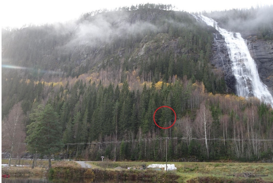
Figur 11. Oversikt over dalside sør for Reiårsfossen. Rød markering viser lokasjonen til løs blokk vist i Figur 12. Bildet er tatt mot vest.
